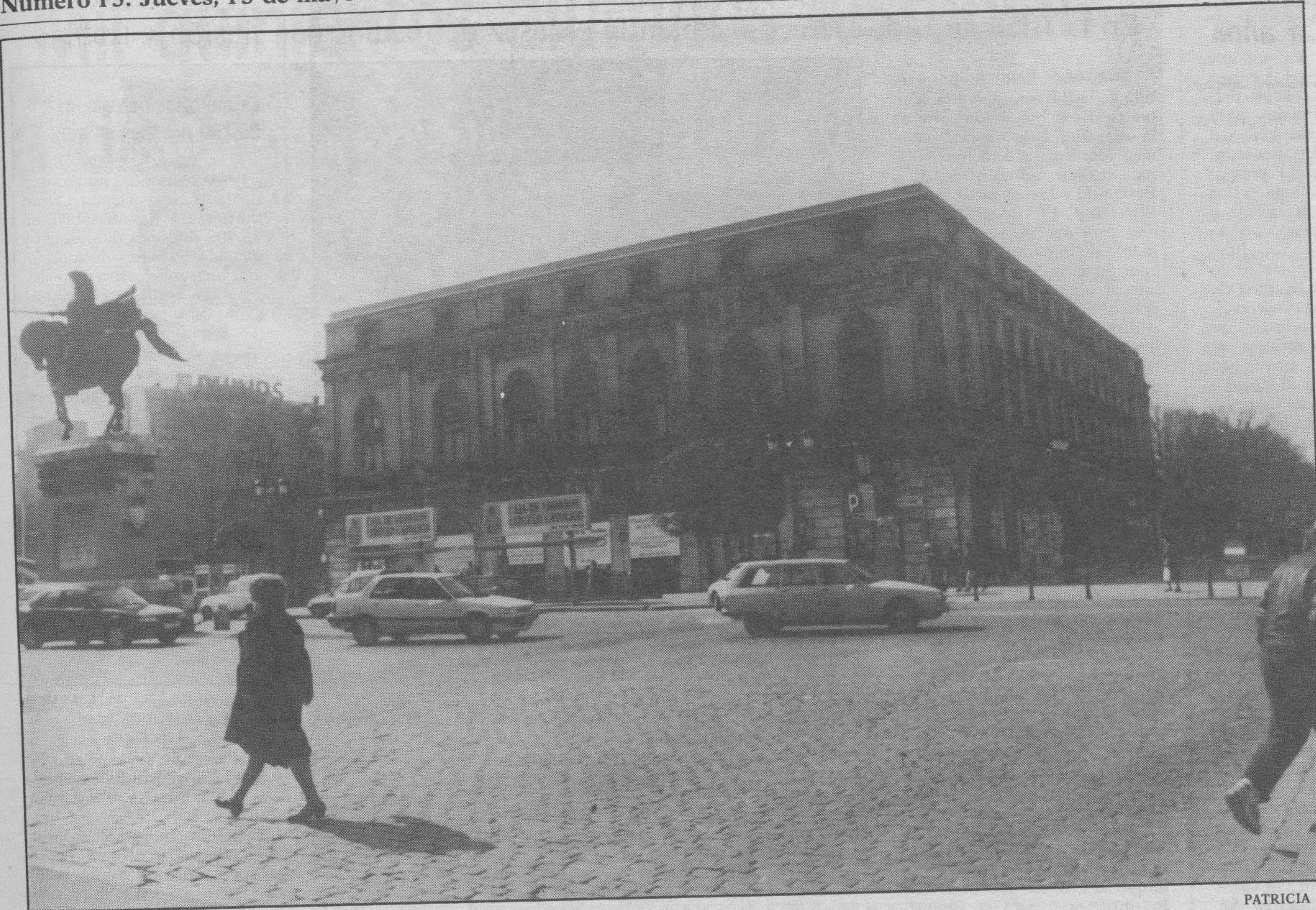
La idea de convertir el Teatro Principal en oficinas municipales tendrá que competir con la de ceder el edificio a la Universidad, después de la petición que cursó la vicerrectora.
