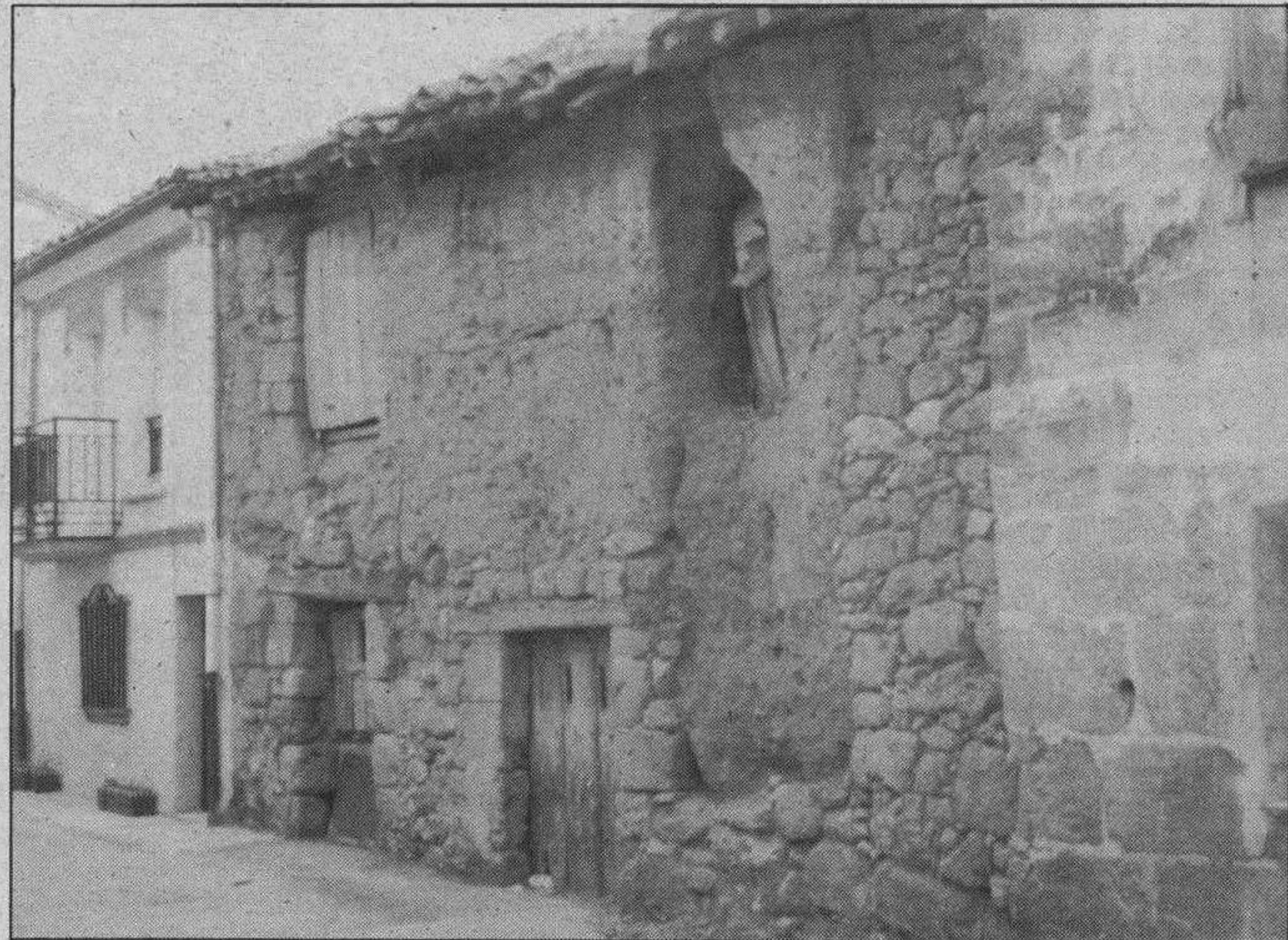
Construcción típica de barro dedicada a corral y bodega.
