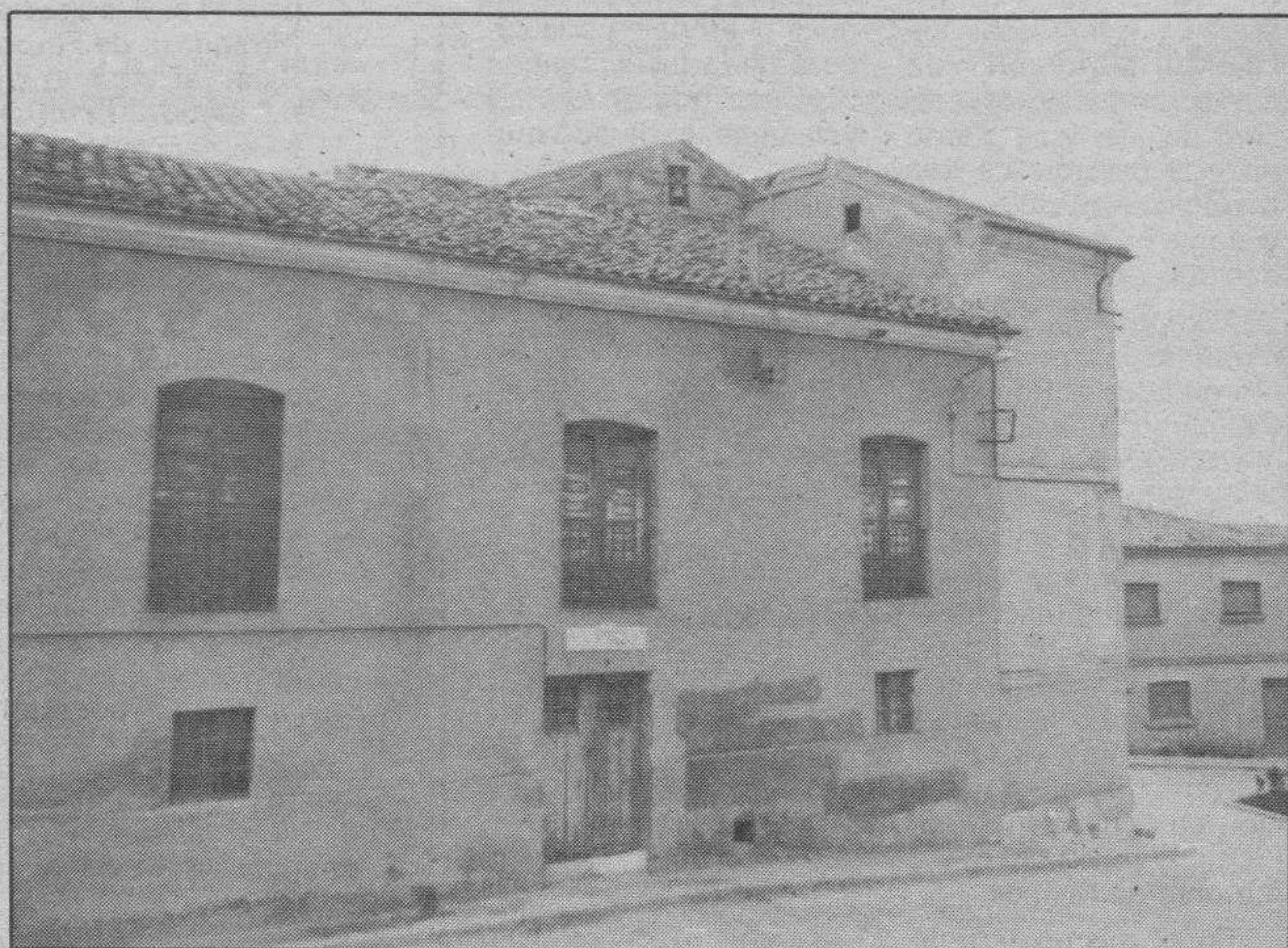
El edificio conocido como la Imprenta, en La Horra, albergará unas habitaciones, comedor y lavandería destinados a la Tercera Edad. Foto Lara.
