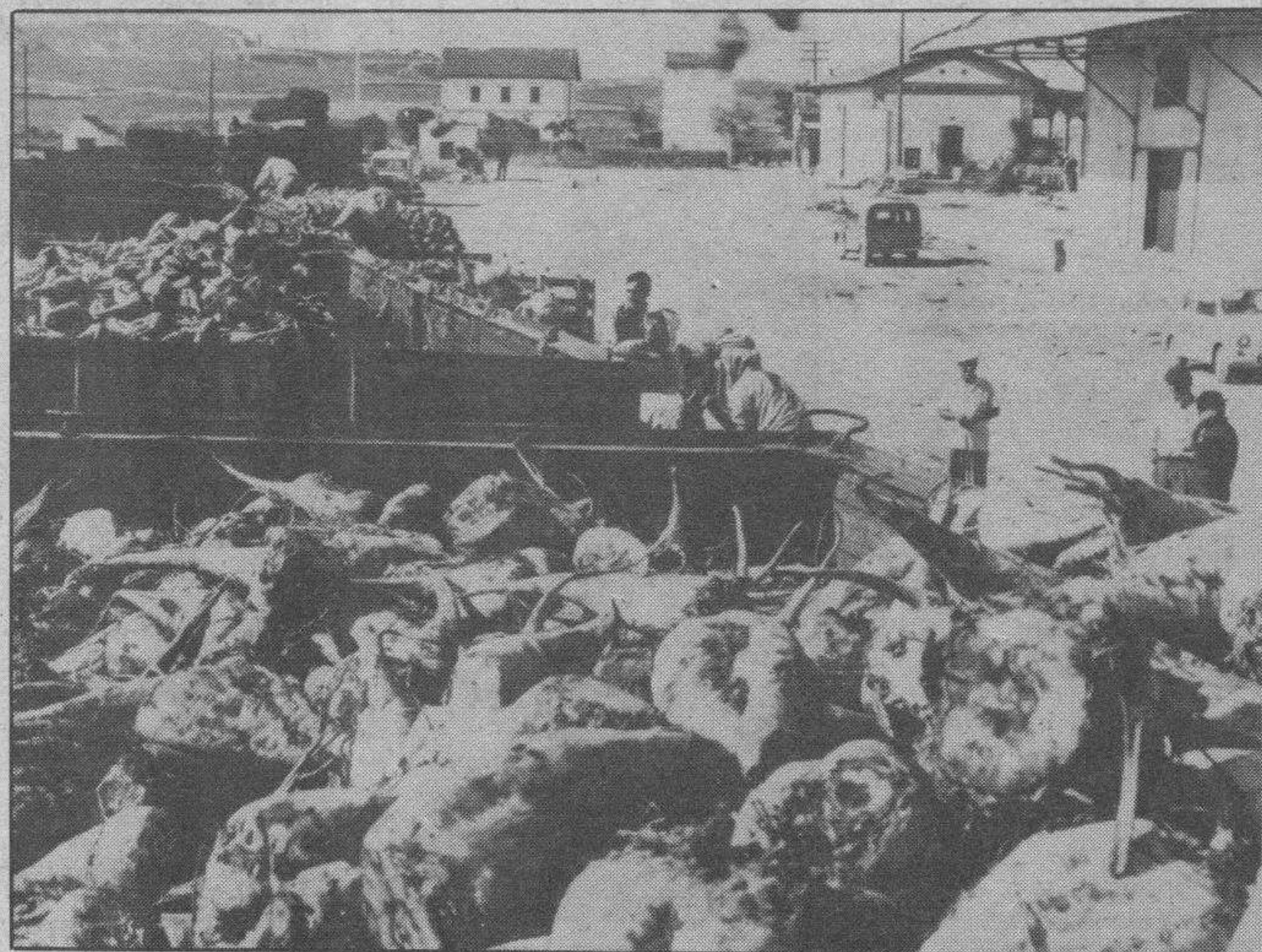
La explotación de remolacha está atravesando serias dificultades. Foto Archivo.
