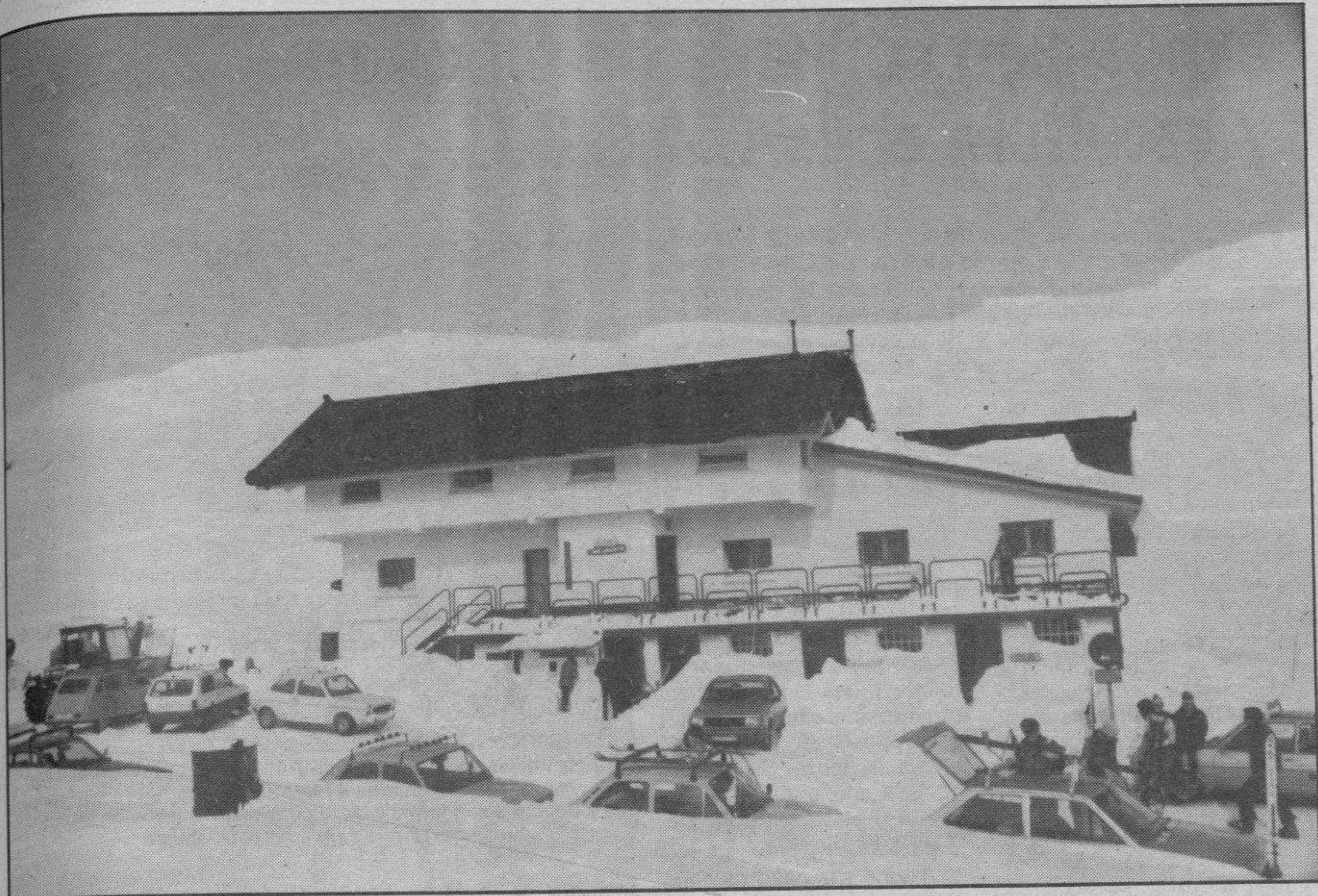
Vista panorámica del complejo invernal de La Lunada, en la localidad de Espinosa de los Monteros. Foto: Archivo.
