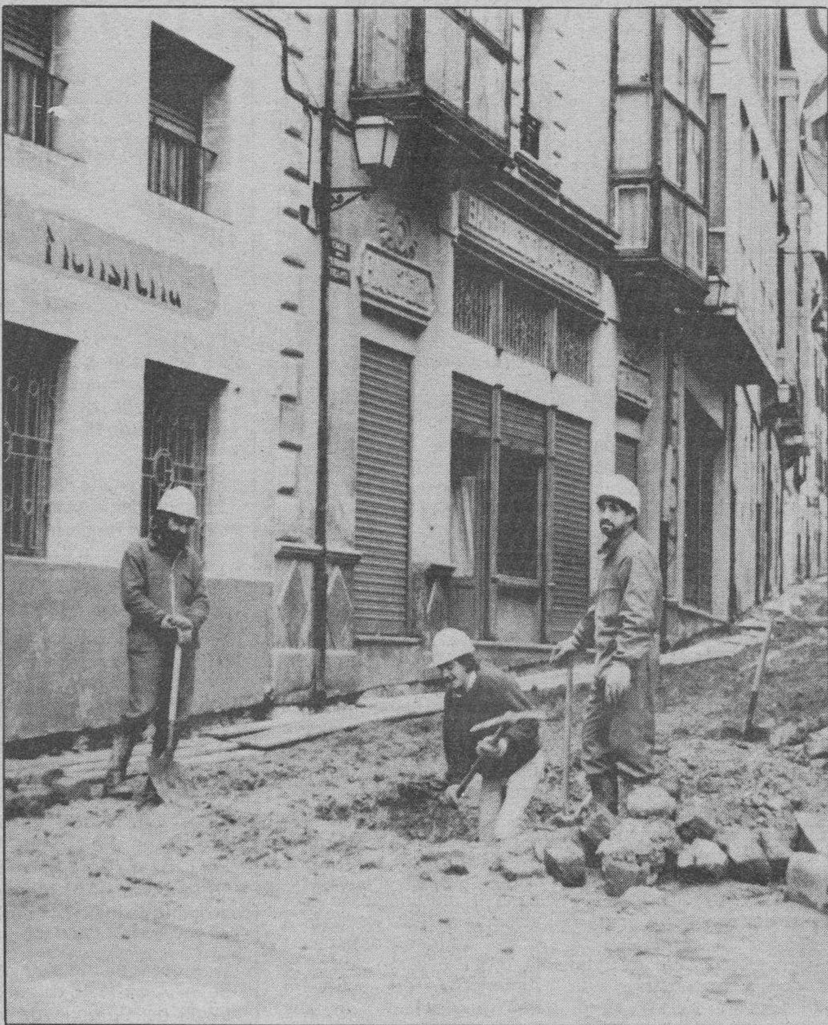
Obras de mejora de la calle Mayor, de Medina.
