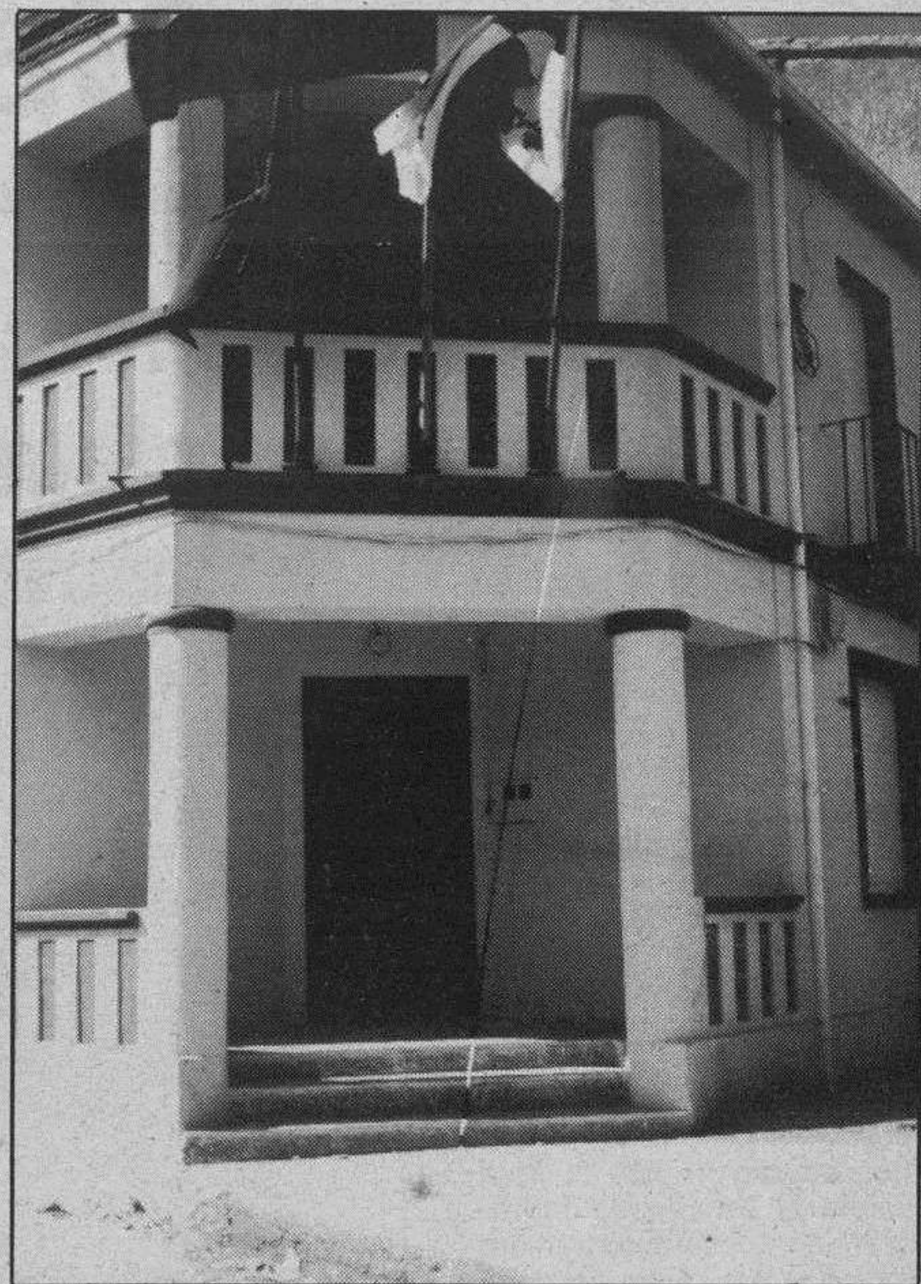
Fachada principal de la nueva Casa Consistorial de Villasandino.
