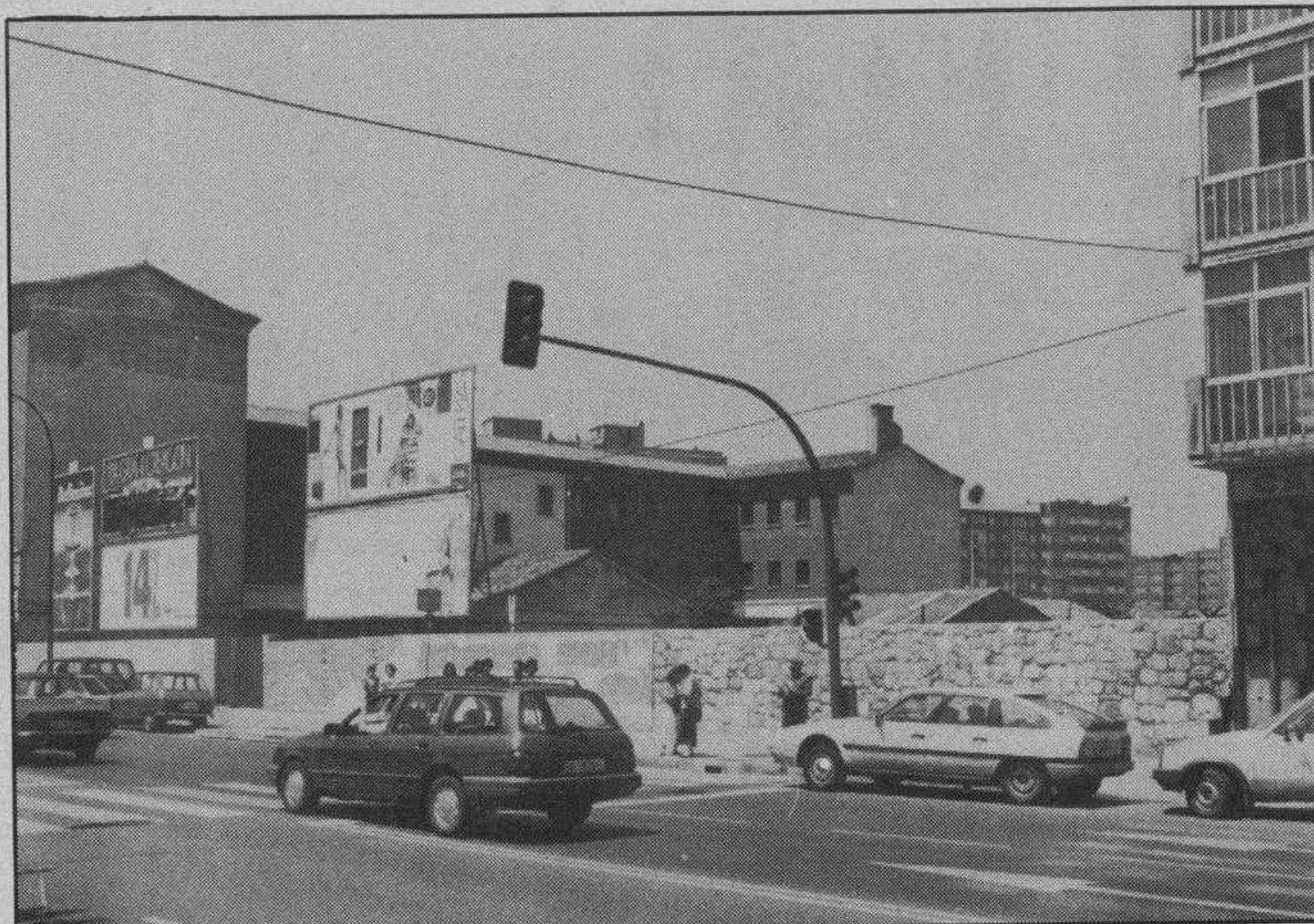
Este es el solar donde se iniciarán las obras del nuevo establecimiento hotelero. El plazo de ejecución es de 14 meses. (Angel Ayala).
