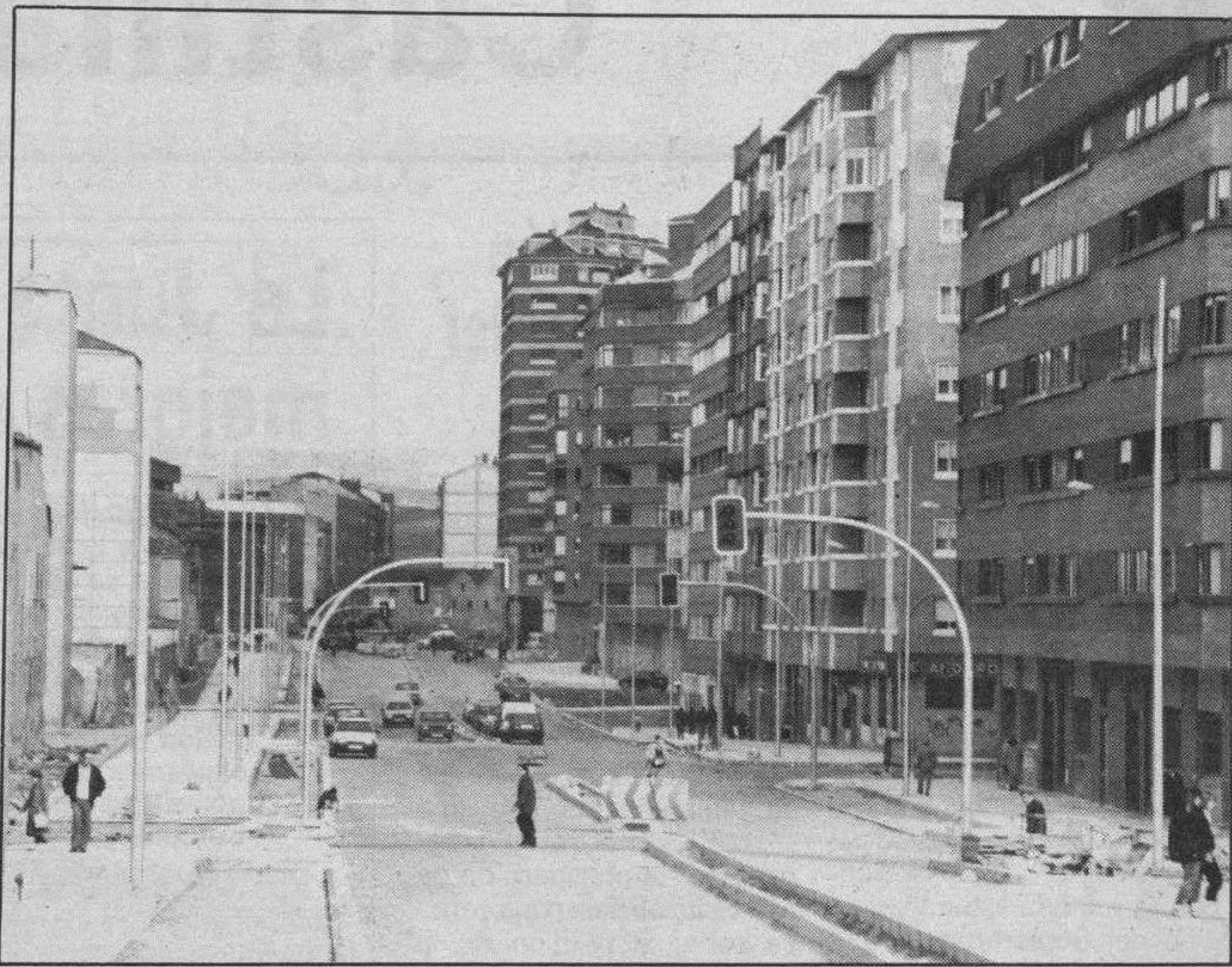
El ritmo de las obras de la Ronda fue el único tema tratado en la última comisión de gobierno municipal. En la foto vemos un aspecto de la Ronda hace algunas fechas, si se cumplen los plazos, en breve veremos mayores realizaciones. (Foto Truchuelo).
