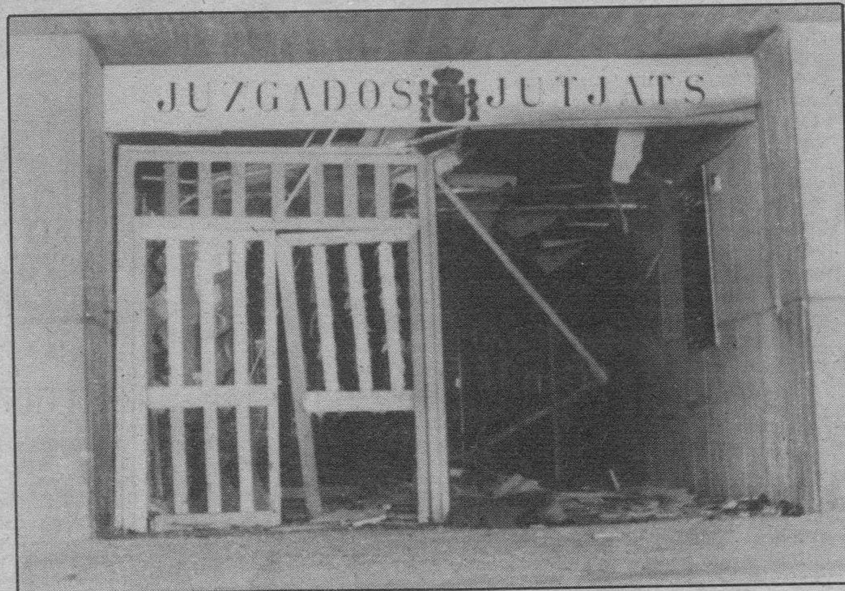
Fachada principal del juzgado de Tarrasa, totalmente destruida. Efe
