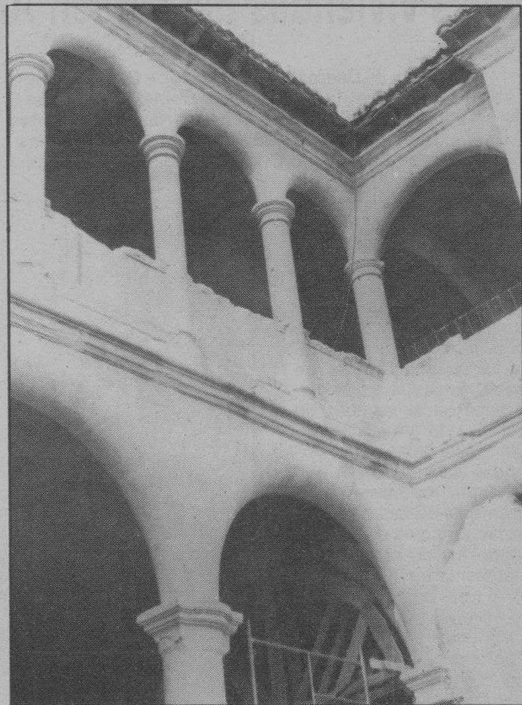
Vista exterior del monasterio que también está siendo objeto de restauración.
