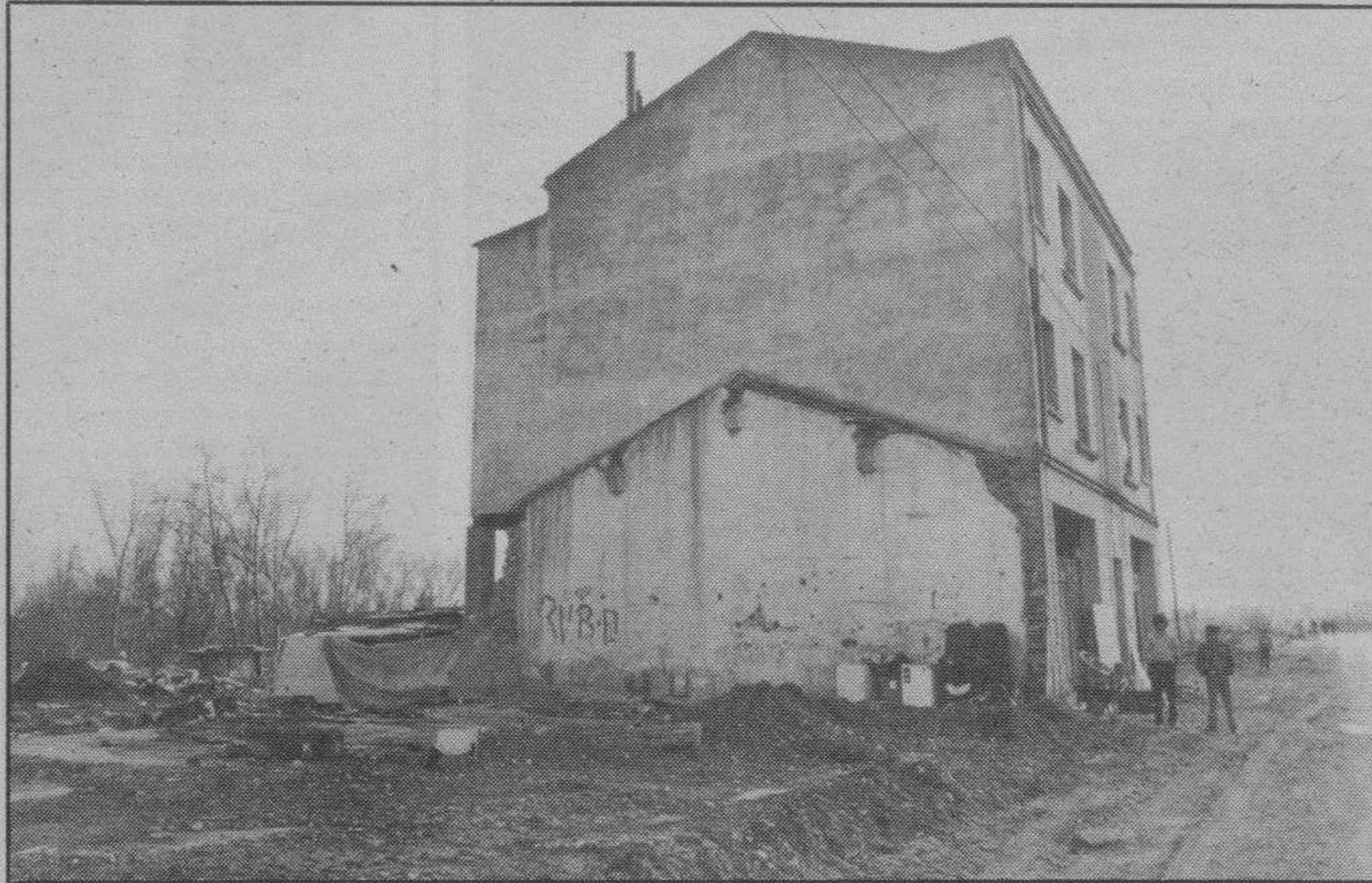
Casa que será derribada en la carretera de Soria. Foto Lara.
