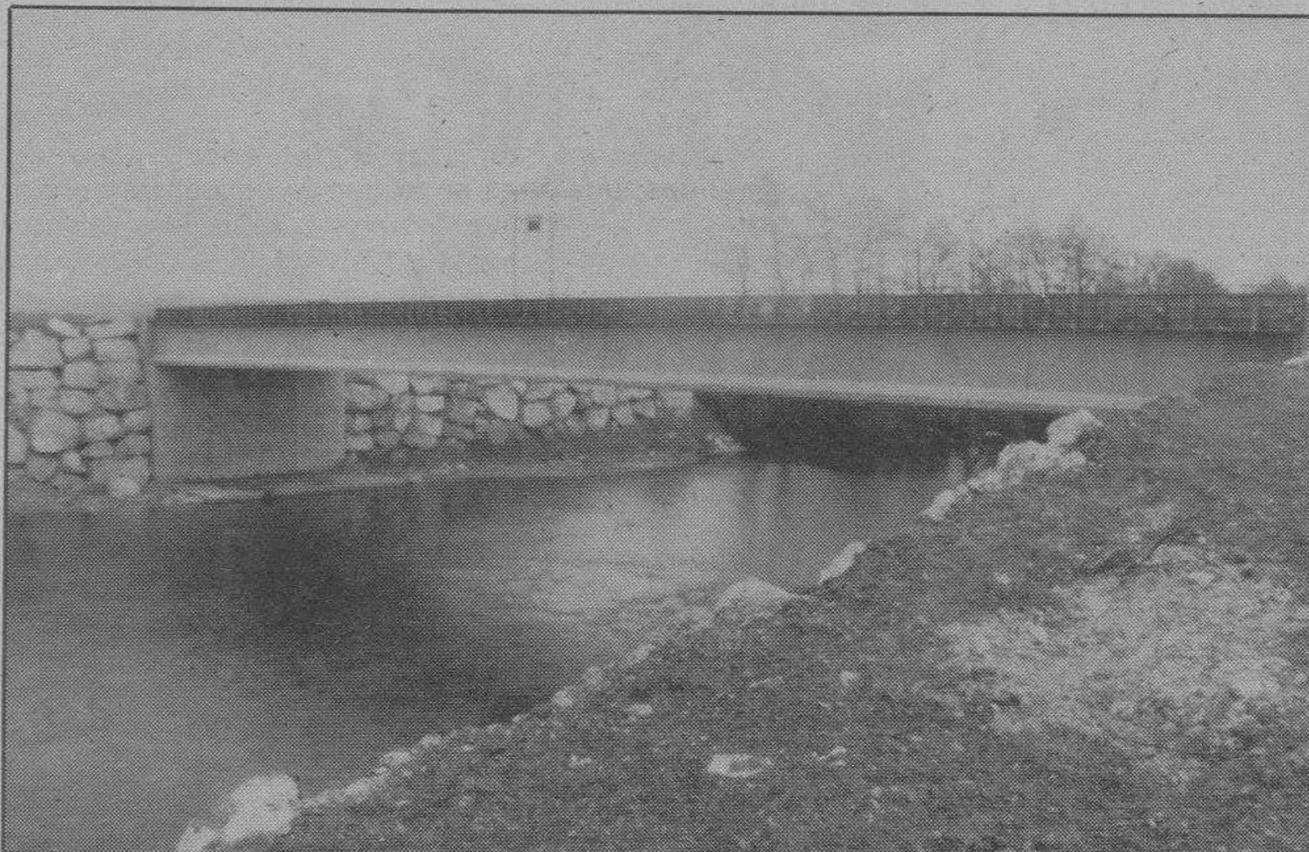
Nuevo puente y trazado de carretera en Quintanilla de Pienza.
