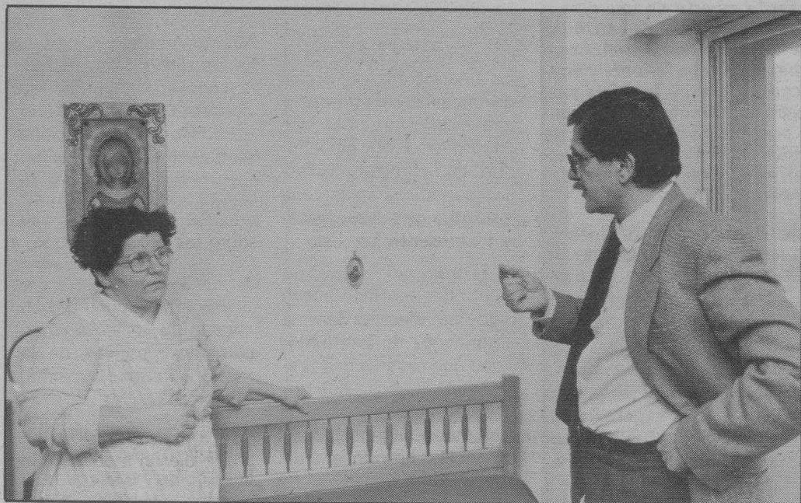
Esteban Riera en una de las habitaciones afectada por humedades.
