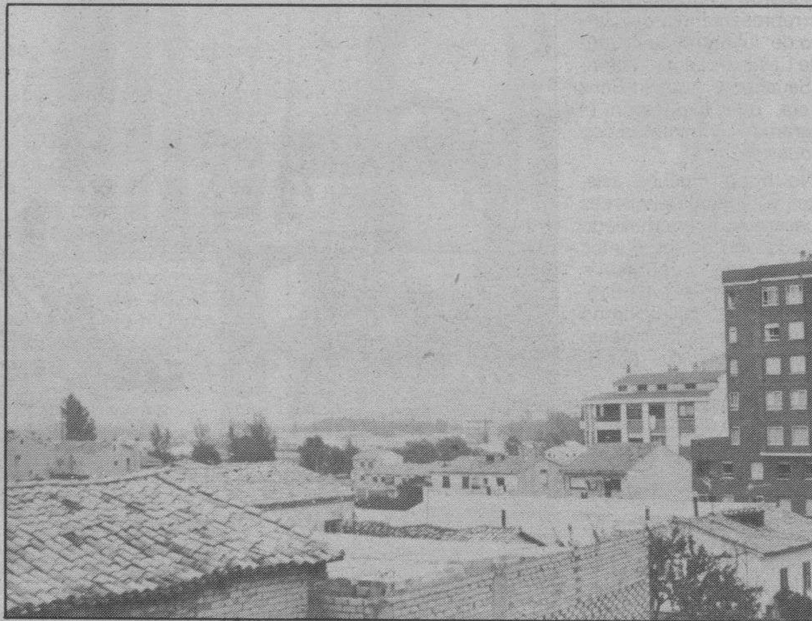
Briviesca: Contraste entre las nuevas edificaciones y construcciones antiguas, que poco a poco van desapareciendo.
