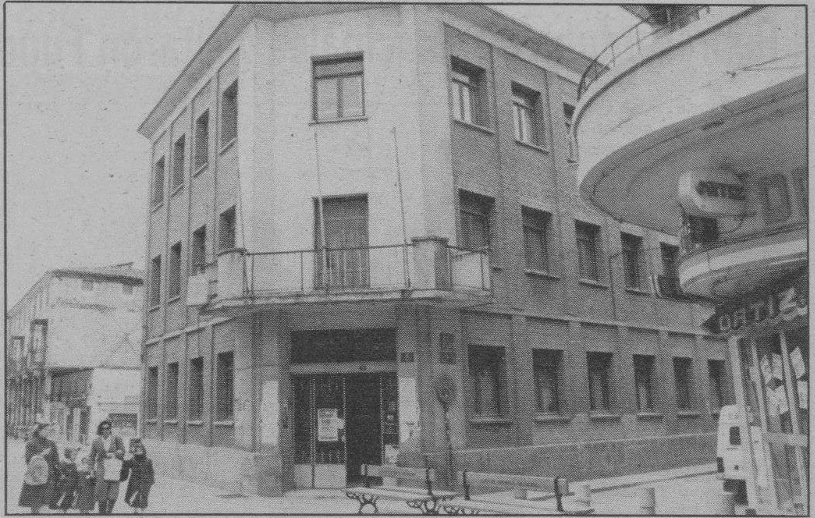
Construcción de la Casa de Cultura y acondicionamiento de la de Sindicatos. — El edificio de la fotografía, conocido como Casa de los Sindicatos, fue en su día objeto de atención porque se estudiaba la posibilidad de derribarlo e incluirlo en el proyecto de la Casa de Cultura, que se va a construir pared con pared, casi. No hubo acuerdo, y se quedará ahí. Sin embargo, la casualidad hace que la misma empresa constructora de la Casa de Cultura, al tiempo que iniciará estas obras, va a acometer el acondicionamiento del local, por otra parte largamente reivindicado, lo cual costará a la delegación de trabajo unos diez millones. La obra tiene que estar entregada al parecer en tres meses. Foto Lara.
