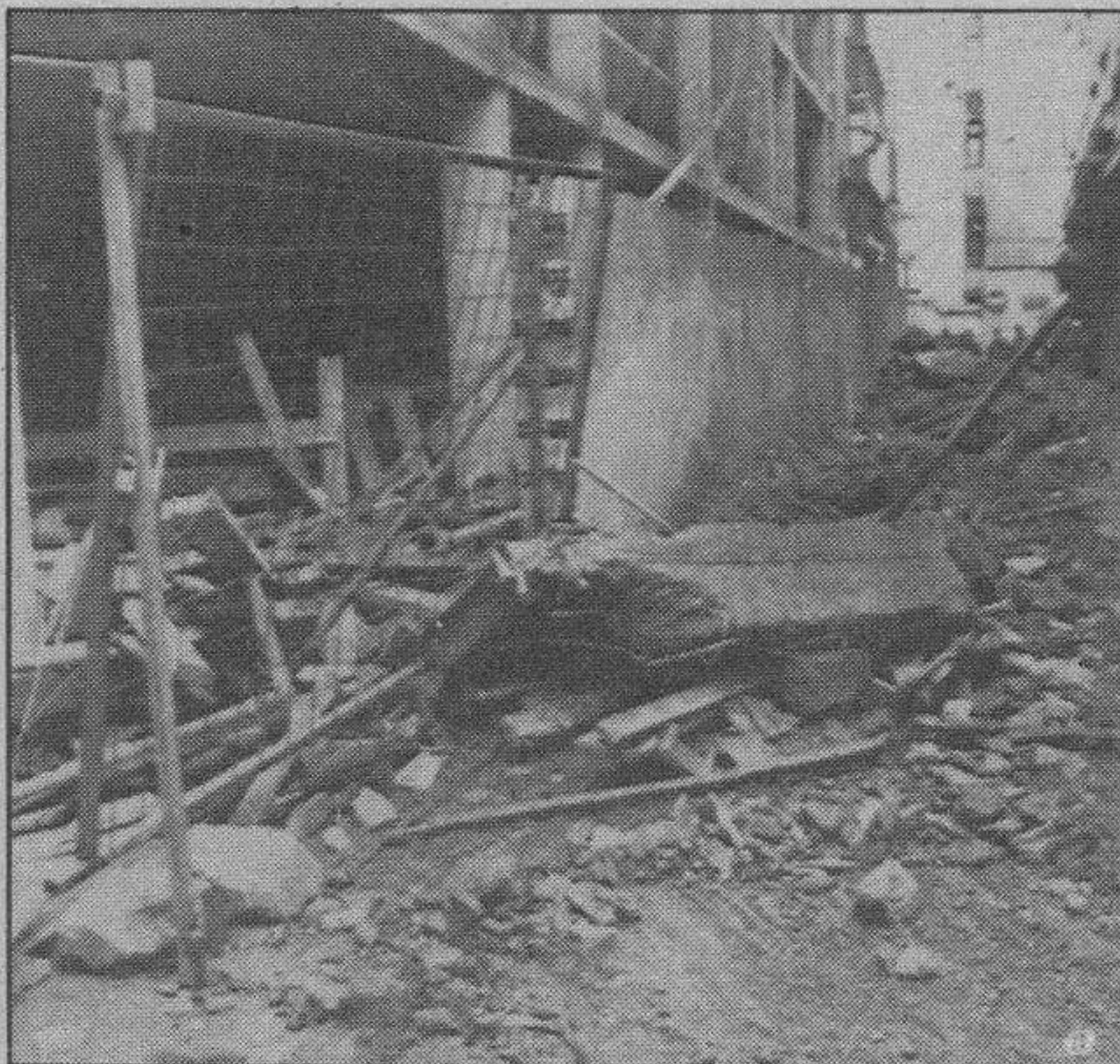
Los escombros invadieron la vía pública, causando dos muertes. Foto Efe/Archivo
