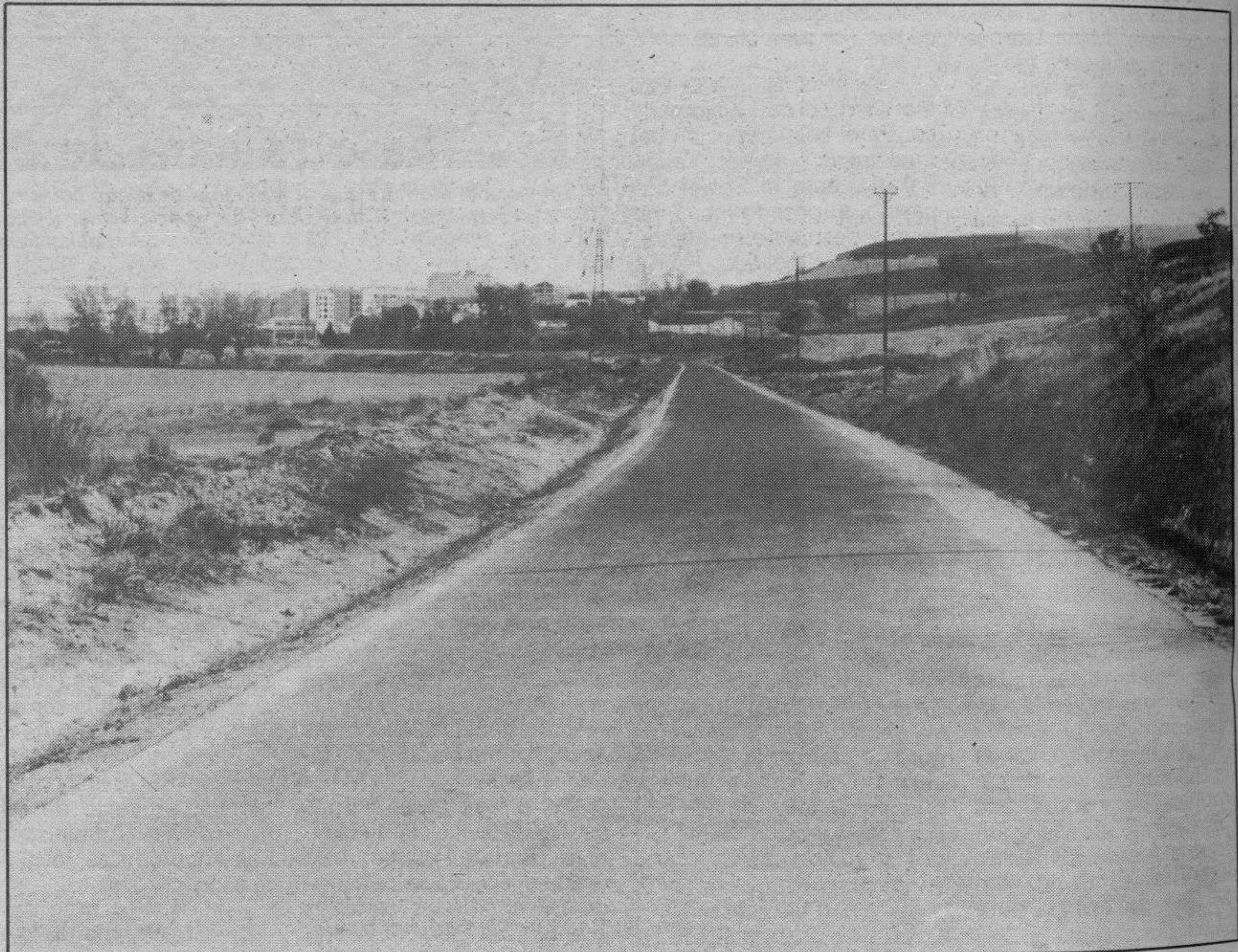
Reparado el Camino de San Zoles. — La fotografía nos muestra el camino de San Zoles que nos lleva hasta el Hospital del Rey desde la carretera de Arcos. Es un paso que evita atravesar la ciudad y que es utilizado por quienes lo conocen. Se han hecho estos trabajos de mejora que son apreciados por los burgaleses que aprovechan esta pequeña «circunvalación».
