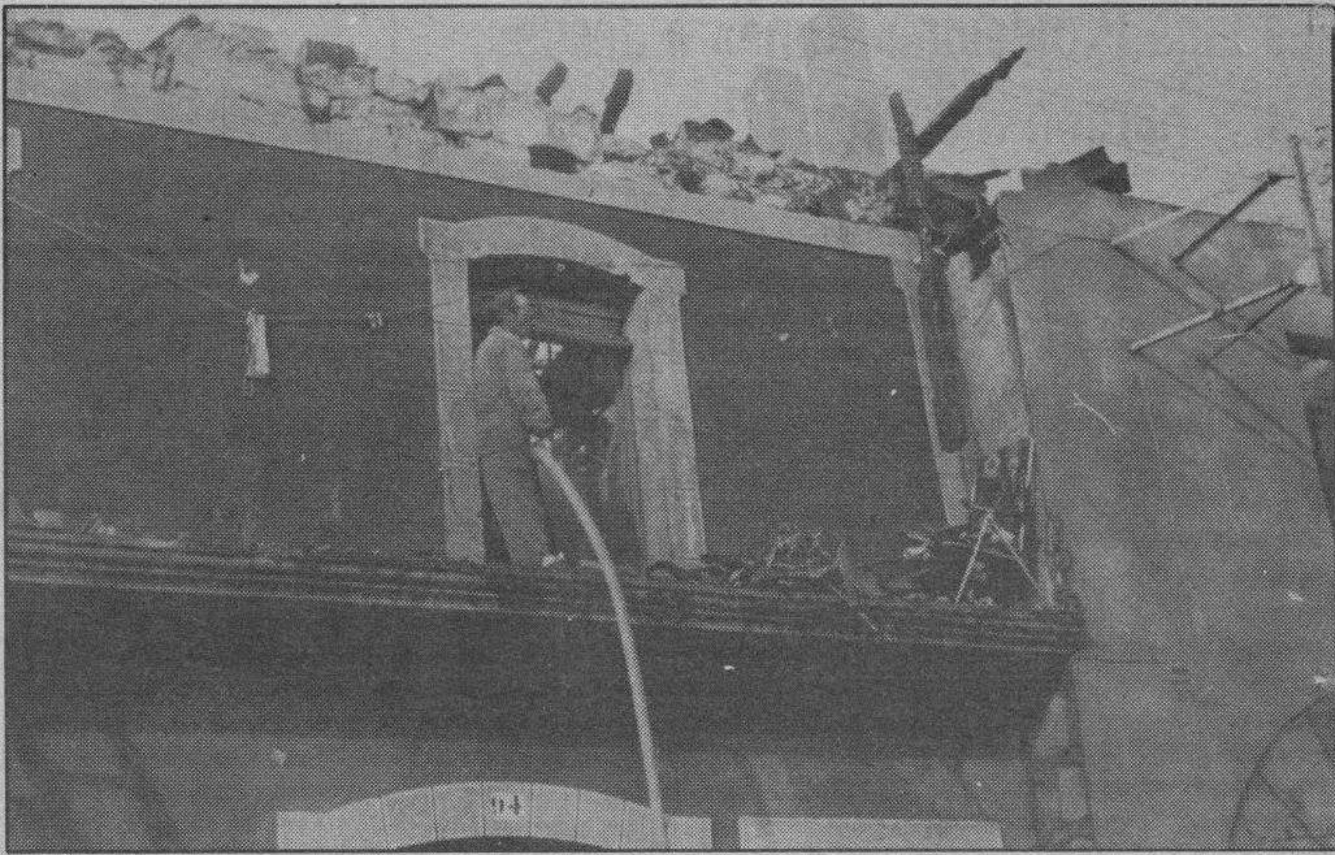
Un corto circuito parece la causa probable del incendio que se prolongó durante más de cuatro horas. Foto Antonio Núñez.
