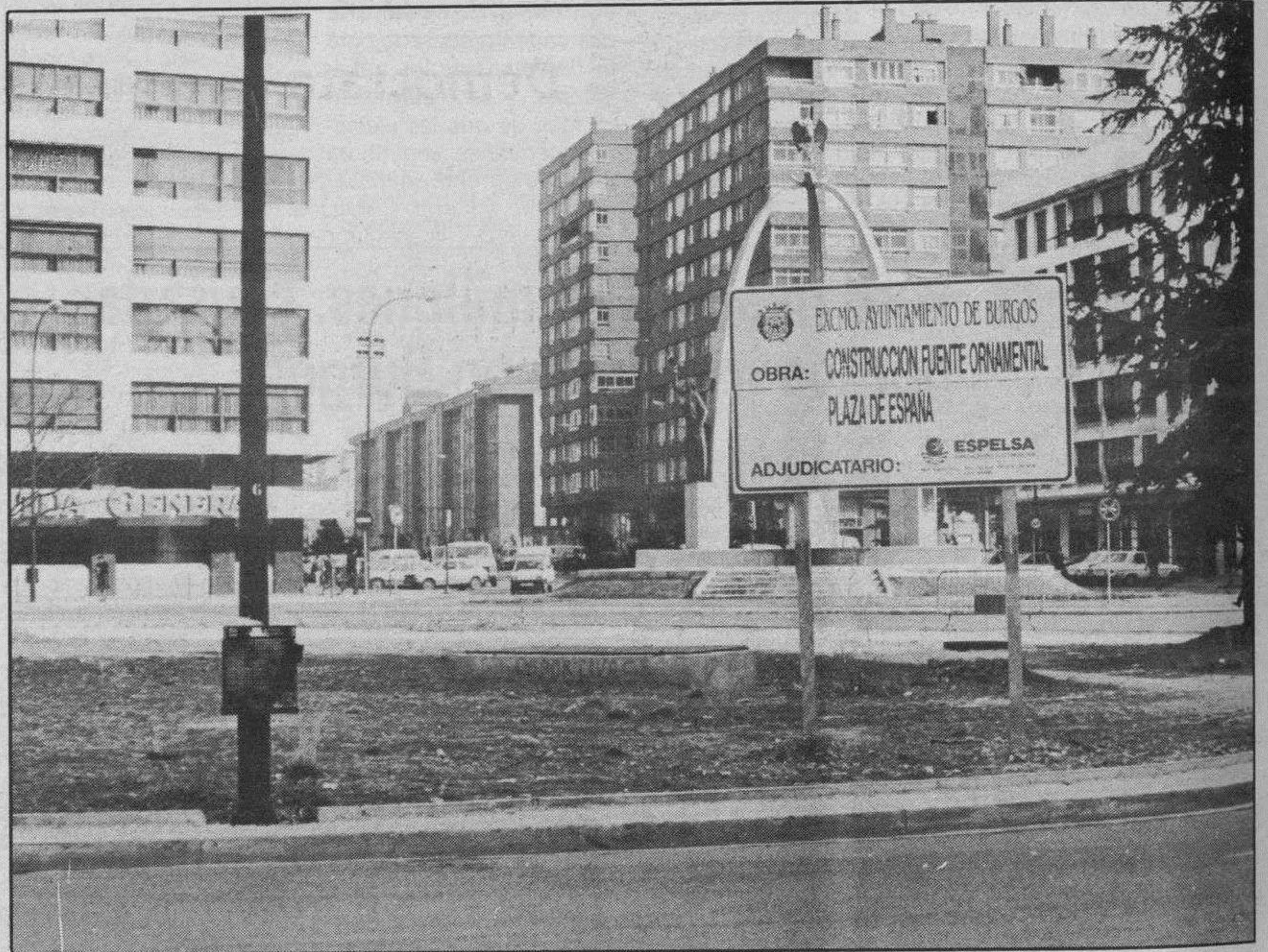
Pronto se instalará la fuente luminosa. — La Plaza de España quedará completada muy pronto. En breve se iniciarán ya los trabajos de instalación para en poco tiempo tener montada la fuente luminosa, de acuerdo con el proyecto que prepara la empresa adjudicataria. El cartel se ha colocado y hay curiosidad en la ciudad por saber cómo será este elemento ornamental, del que Burgos ha carecido. Esperemos que esta vez se acierte.
