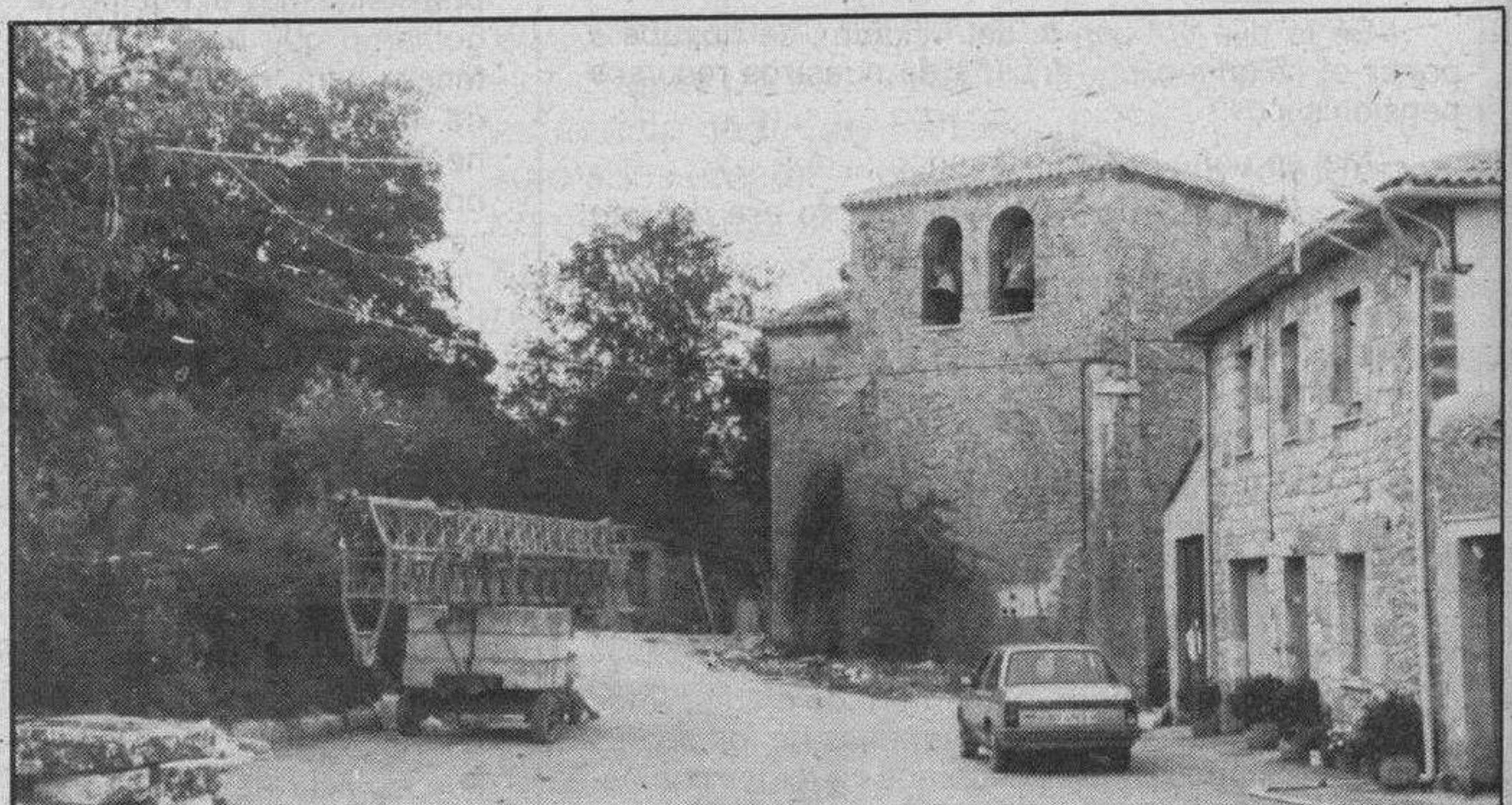
Vista de la iglesia de Ayoluengo de la Lora, recientemente arreglada.
