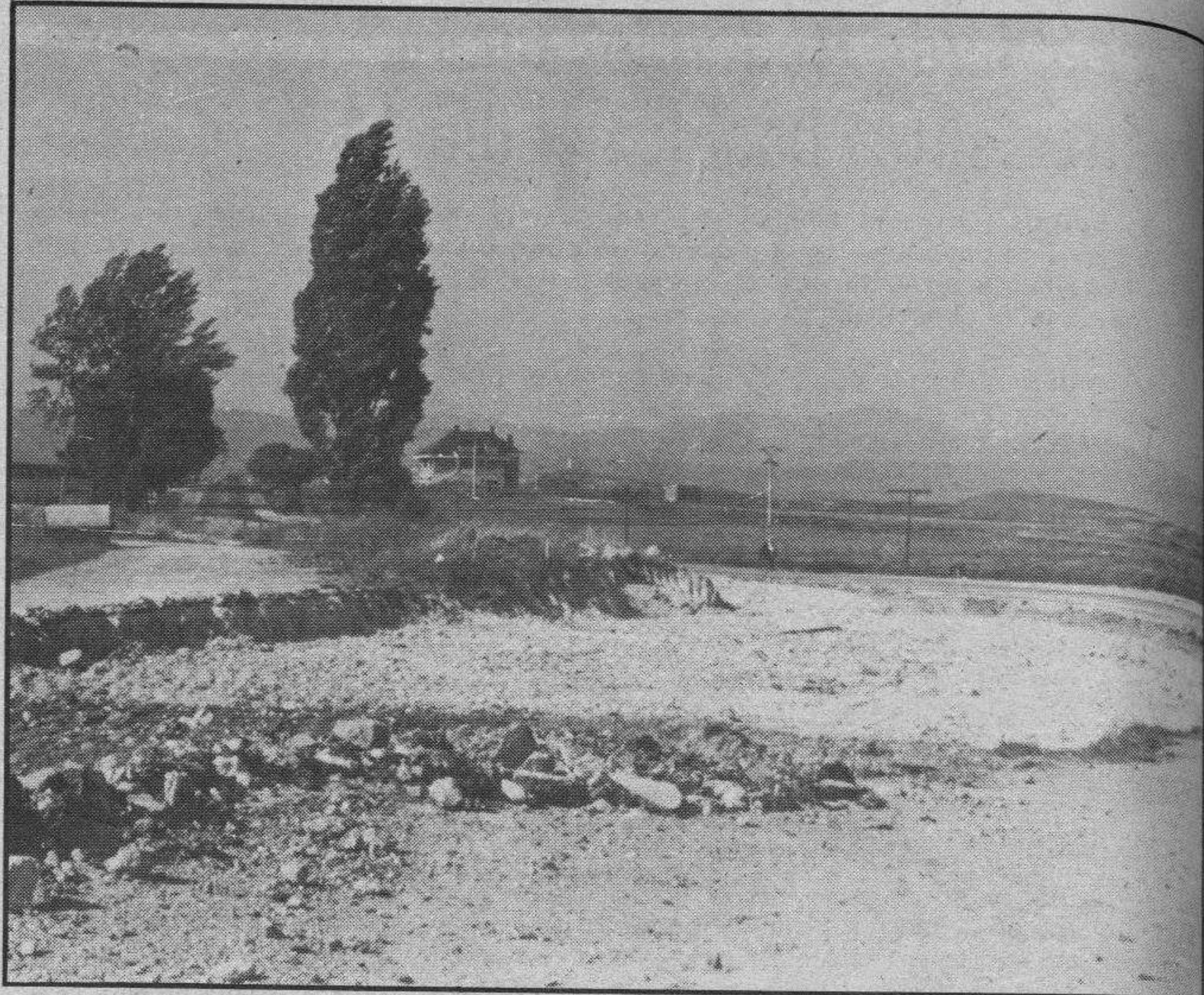
Nuevo acceso al hospital comarcal. — Naturalmente que no con ello la polémica, por cuanto que hay un amplio sector de mirandeses que no está de acuerdo con esta solución, pero lo cierto es que ya han comenzado las obras para construir una parrilla en el enlace de la nacional Madrid-Irún, con el tramo de carretera que a la salida del barrio de Orón, conduce al Hospital Comarcal Truchuelo nos ofrece en esta imagen las obras de explanación que se están realizando en dicha zona.
