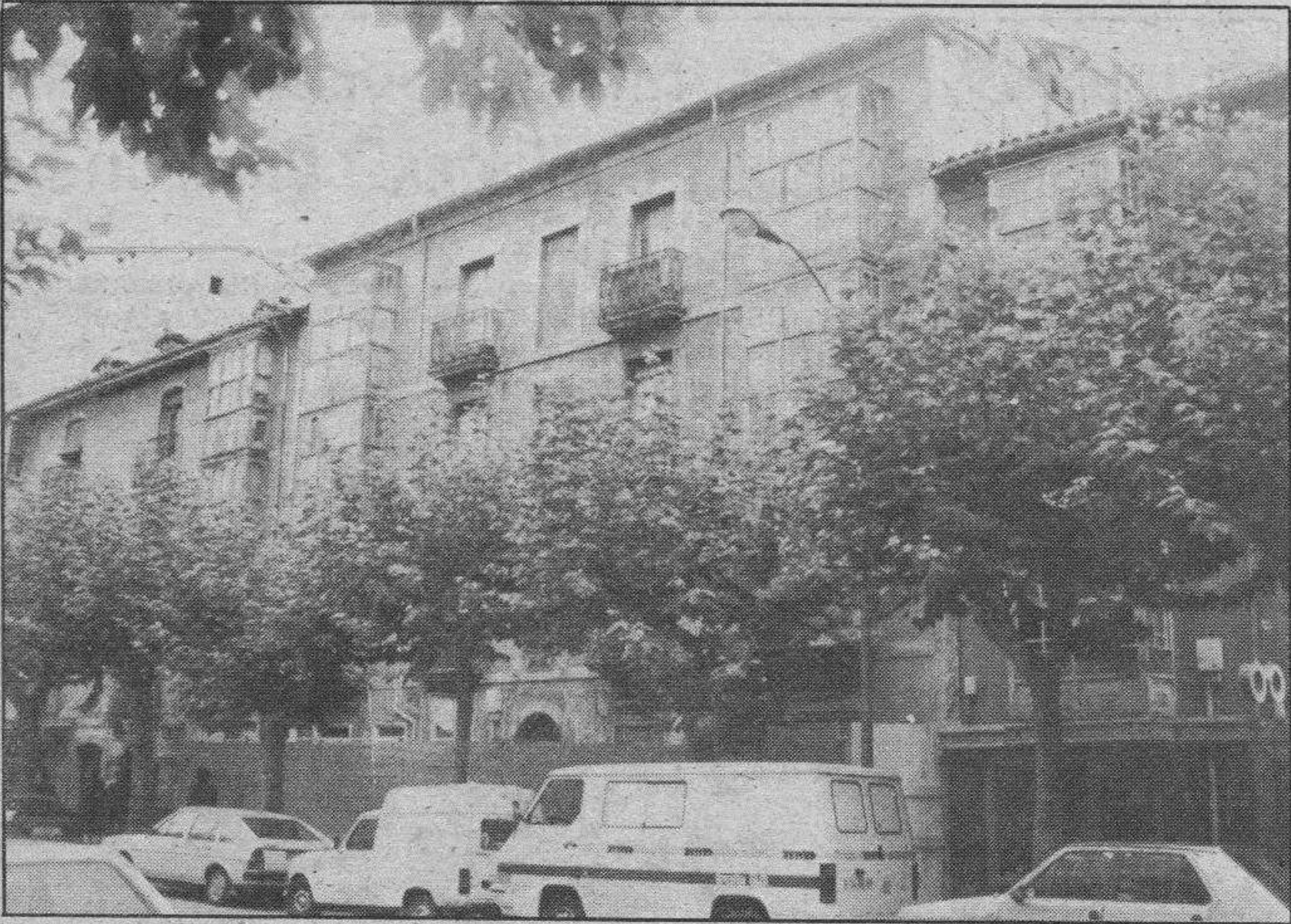
Se ejecutan las obras de derribo de la casa número 14 de la calle de la Estación. — Foto Truchuelo.
