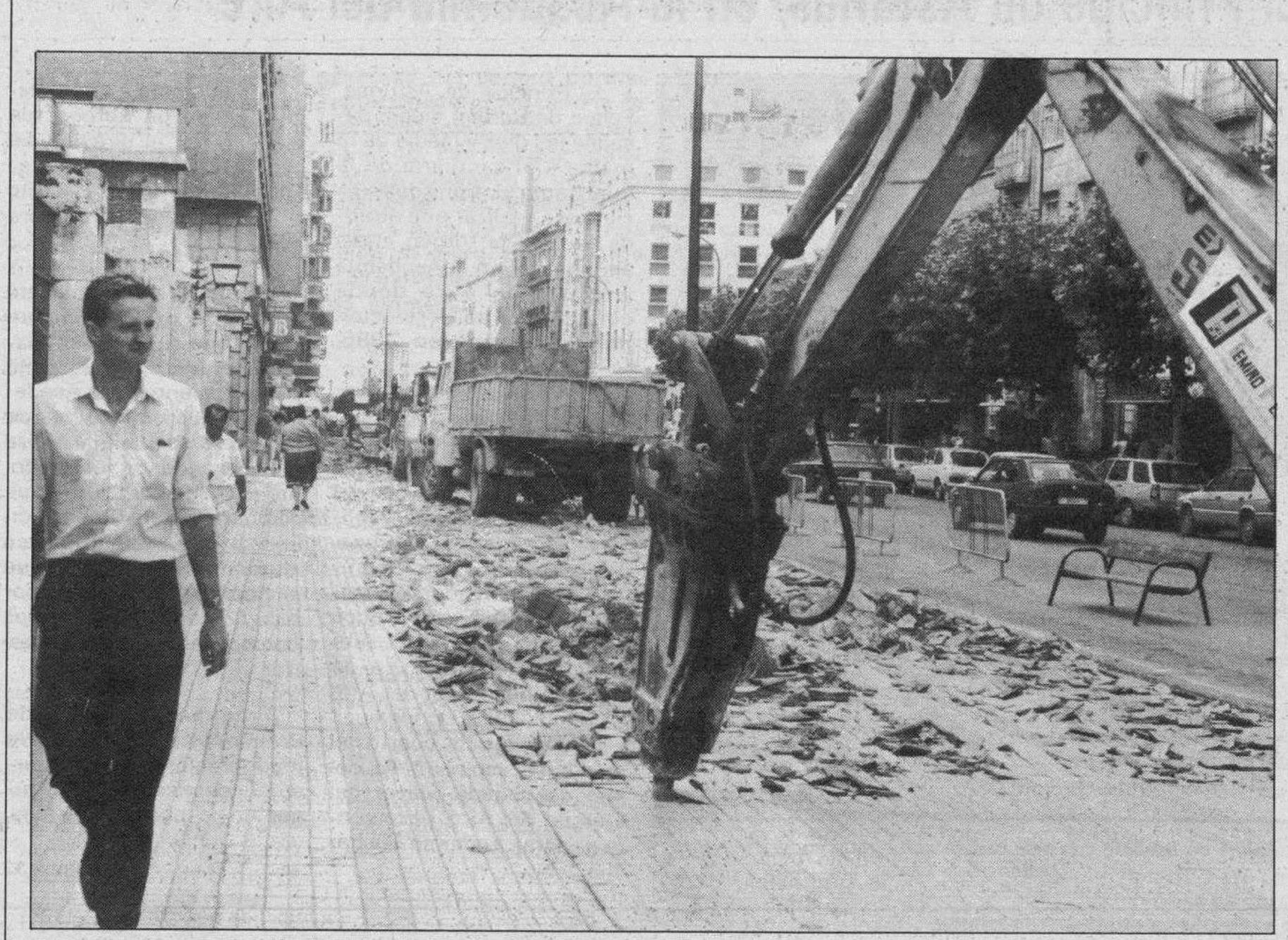
Obras para meter el gas y mejorar la acera. — He aquí una de las fases de las obras de rotura del pavimento para abrir zanjas por donde discurrirá la red de distribución del gas natural en la calle de Vitoria que, a pesar de la intensidad del tráfico en este tiempo, canaliza, además, los trabajos de máquinas y hombres. Después vendrá la nueva ordenación y mejora de la acera.
