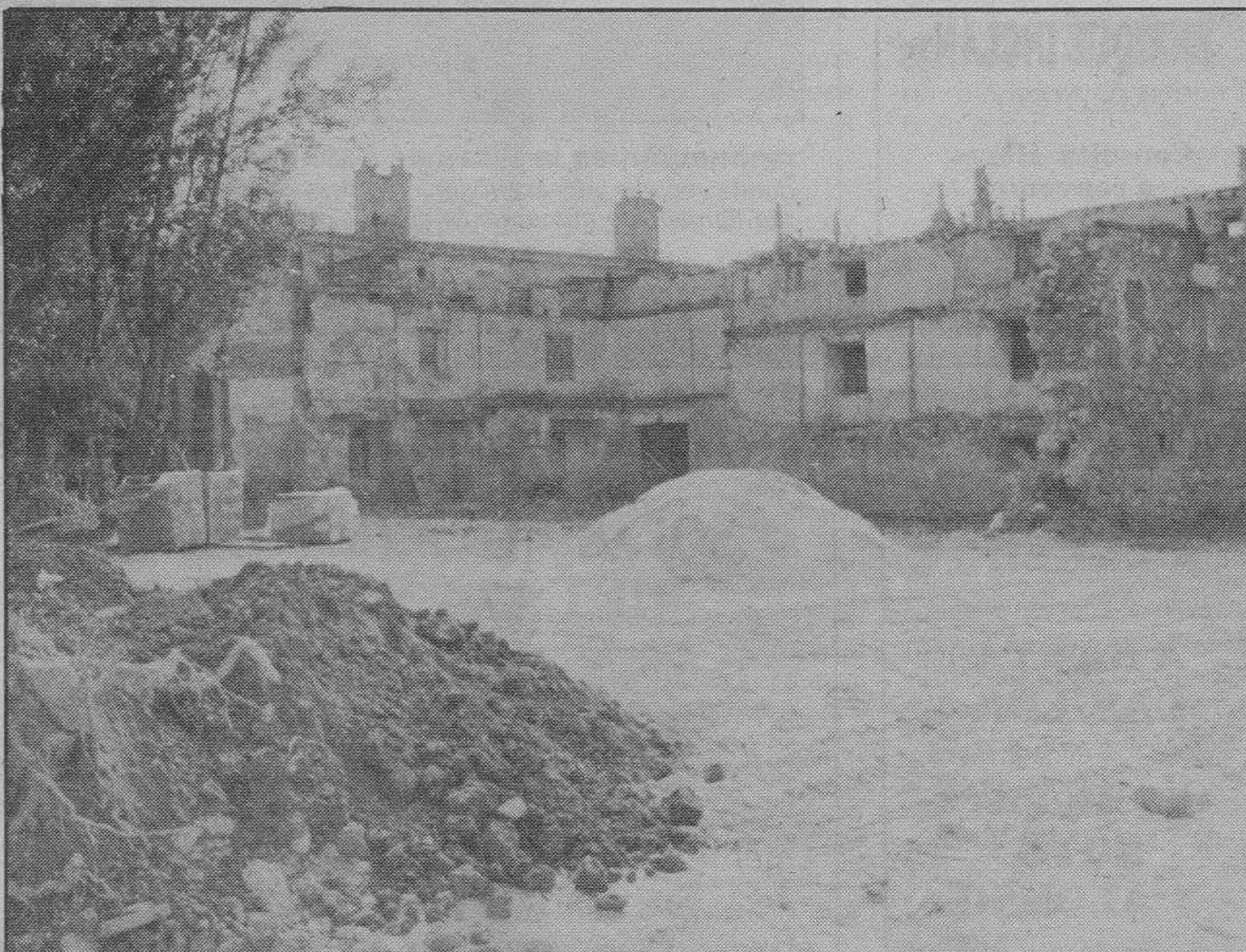
Obras en Hospital del Rey. — Se está realizando el primer plan de desescombro y acondicionamiento de muros del Hospital del Rey, sede de la Facultad de Derecho. Las demoliciones previas a la obra de restauración cuentan con un presupuesto de casi 50 millones de pesetas, según el concurso subasta que fue publicado en Marzo del año pasado.
