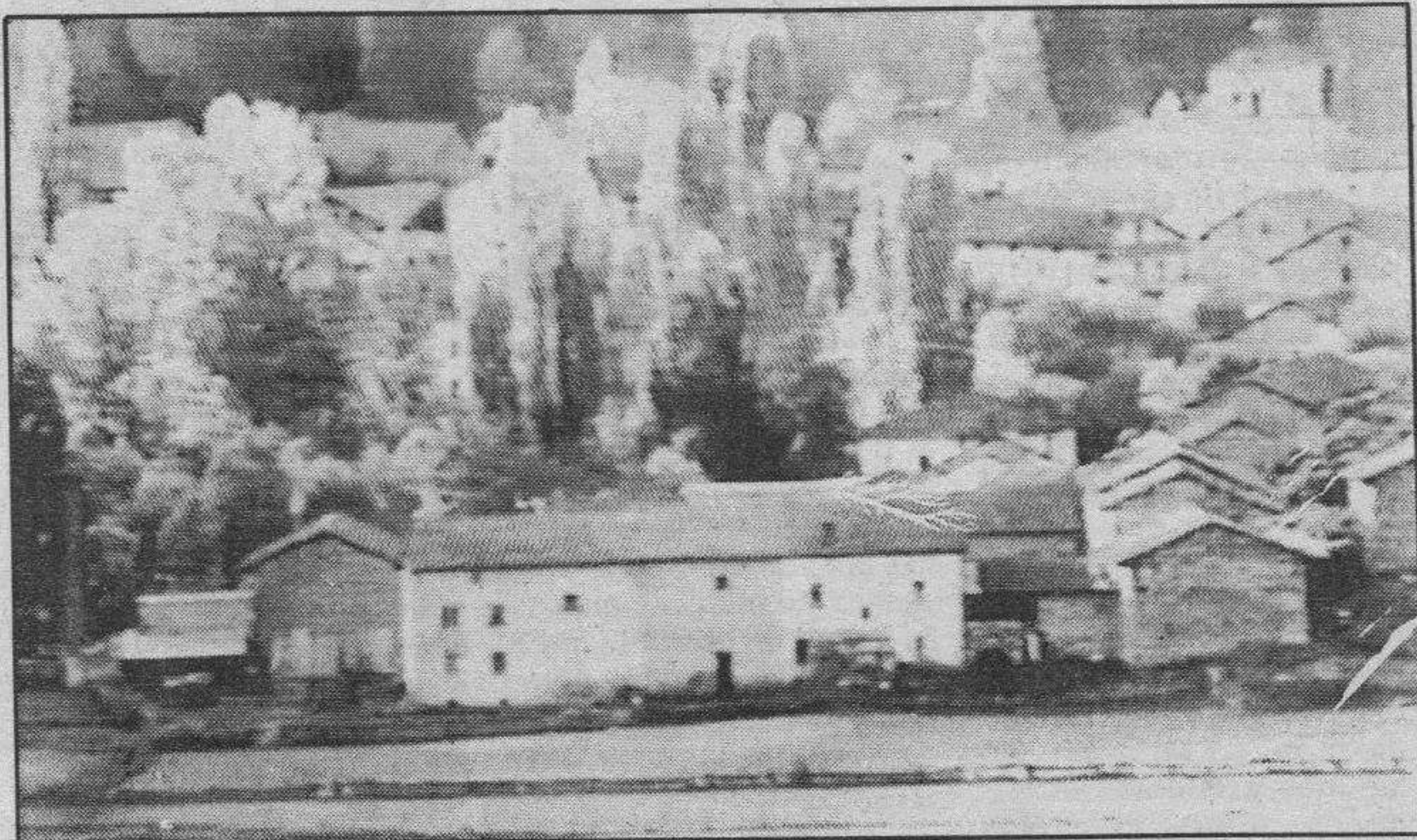
Vista parcial de Riaño, antes de iniciarse las demoliciones.
