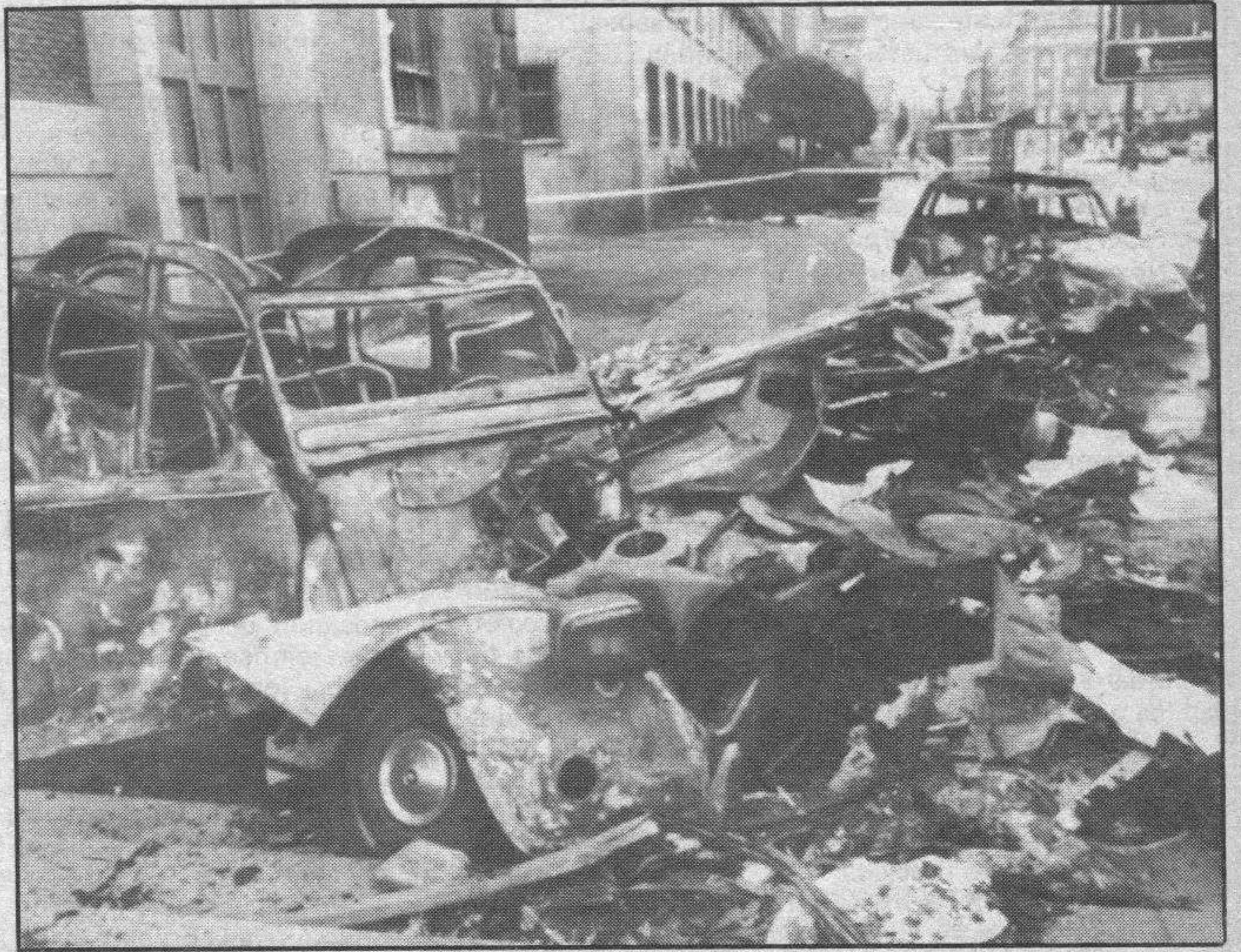
Destrozos en los automóviles que estaban junto al coche bomba en la calle Princesa, frente al Cuartel General del Aire. Los edificios colindantes, que son viviendas militares, resultaron dañadas en los cristales. (Telefoto EFE).
