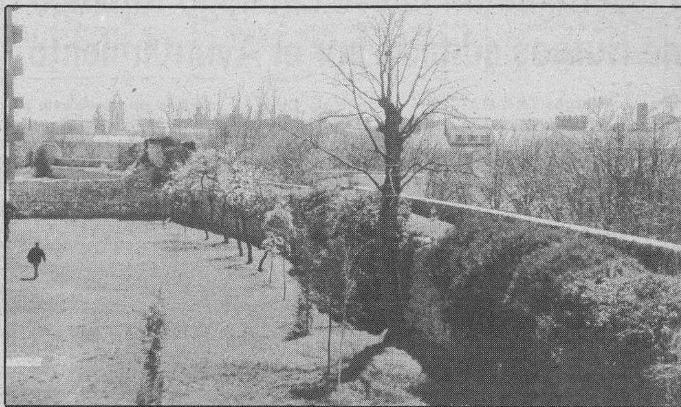
La Comisión Municipal de Gobierno aprobó la contratación de las obras de restauración parcial del interior de la muralla en el paseo de los Cubos.
