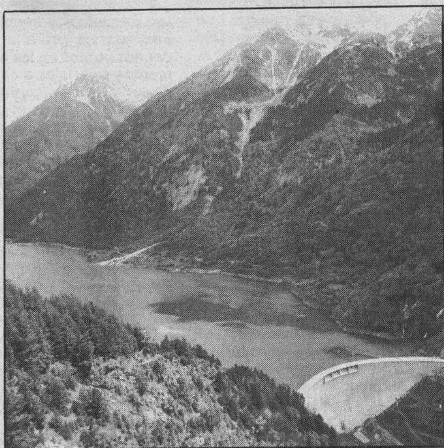
Central hidroeléctrica de Moralets.
