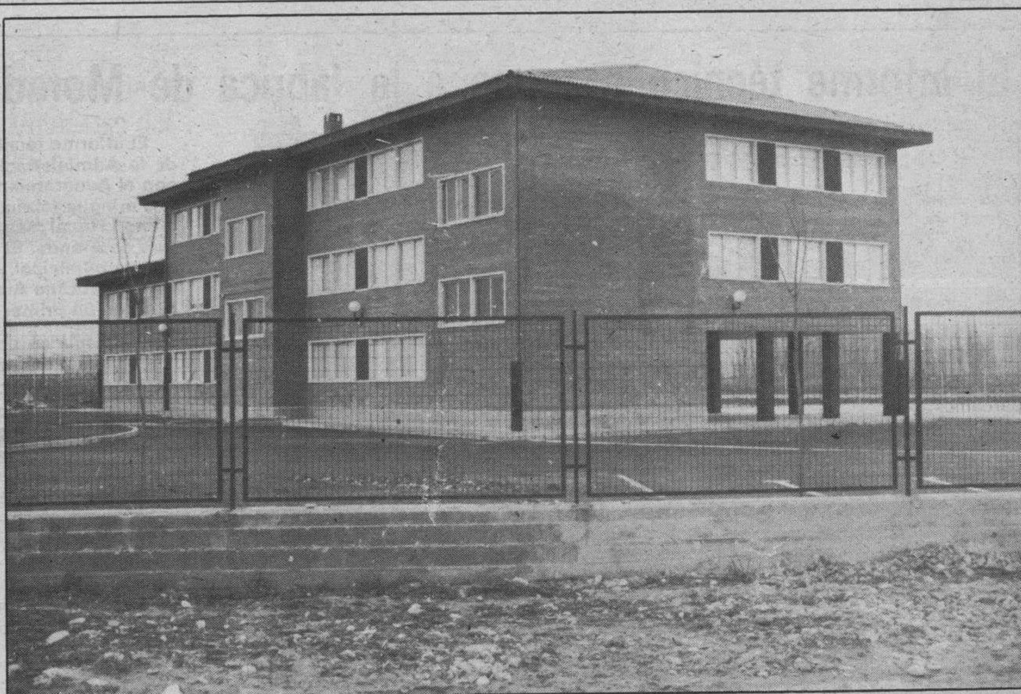
El Colegio de La Charca a punto para prestar servicio. — El edificio está terminado, como puede apreciarse en la foto de Truchuelo. Falta por acondicionar los alrededores en los que sabemos irán jardines y zonas deportivas, unas formando parte del centro escolar y otras, como consecuencia de las urbanizaciones que se han realizado o se están realizando en esta zona del ensanche de La Charca. Este colegio viene a suplir la ausencia del de los Padres Jesuitas en cuanto a E.G.B. se refiere y viene a cubrir una perentoria necesidad del populoso Barrio de La Charca, evitando largos desplazamientos a la población escolar de la zona.
