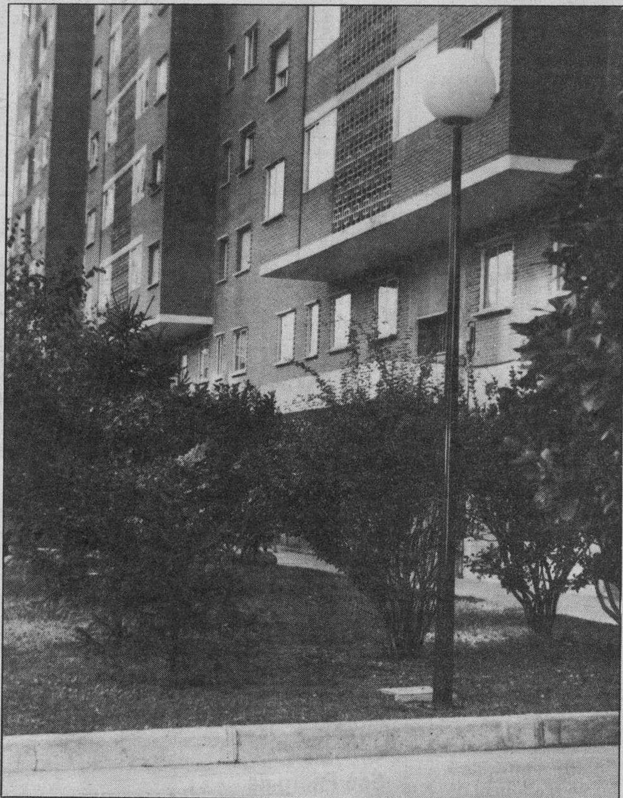
Eficacia municipal. — Algunos vecinos de varios inmuebles de la Avenida del Vena se dirigieron hace poco tiempo a la Alcaldía solicitando que se reforzase el alumbrado de la zona, pues consideraban que era insuficiente. En un plazo inferior a un mes se ha puesto de manifiesto la eficacia municipal —que desean se resalte en esta misma sección— colocándose estas farolas que ornamentan estos bonitos jardines. La verdad es que el vecindario está encantado. Ahora a conservarlas.
