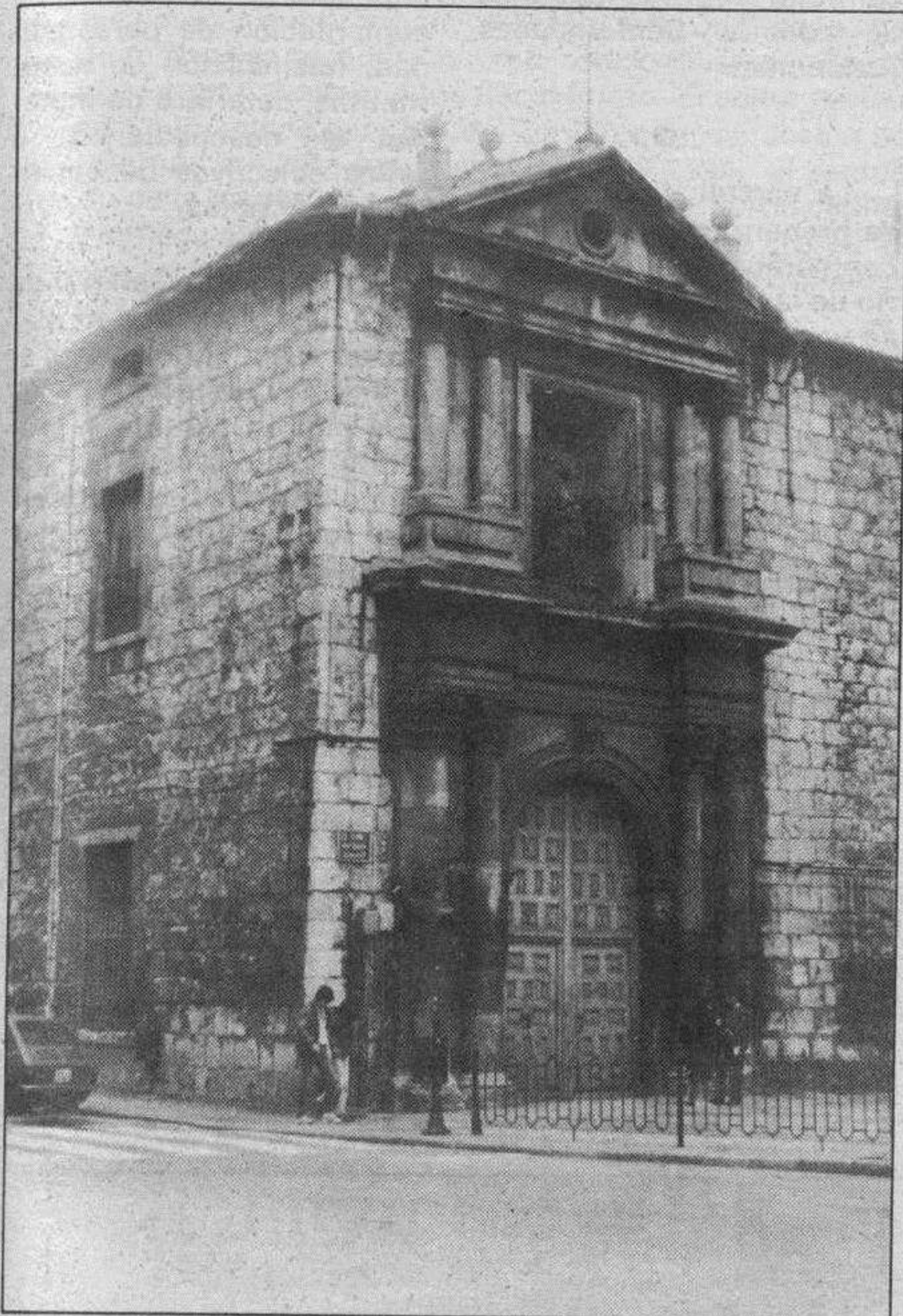
Aprobadas obras de urgencia. — La Junta de Castilla y León aprobó ayer un proyecto de obras urgentes de restauración en el Hospital de la Concepción, por importe de ocho millones y medio «ante el grave deterioro que sufre» este edificio declarado en 1946 monumento histórico-artístico. Se trata de afrontar la situación de ruina, pero la solución definitiva habrá que adaptarla también inmediatamente.
