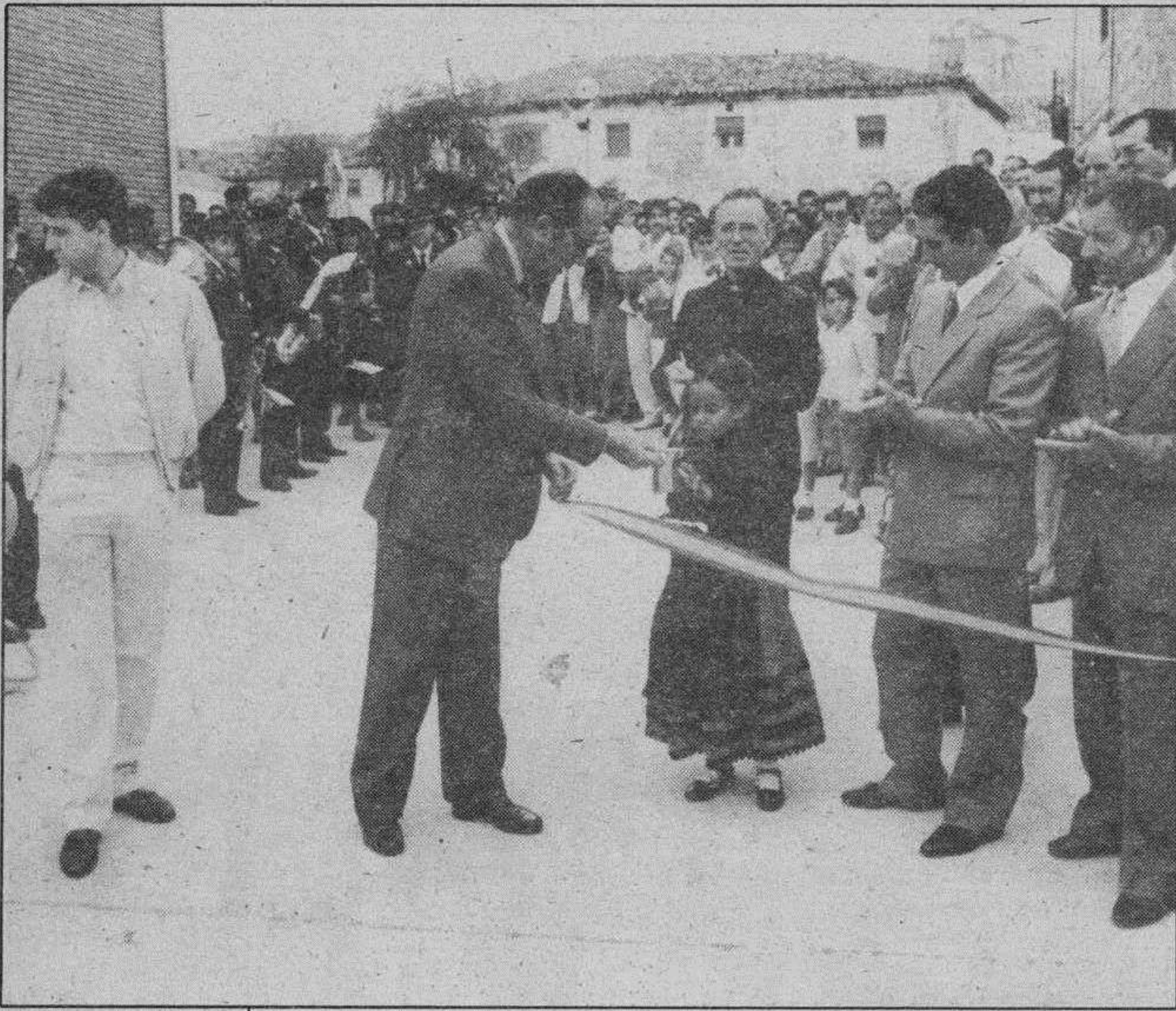
La inauguración de la pavimentación de las calles en Estépar. Foto Villafranca
