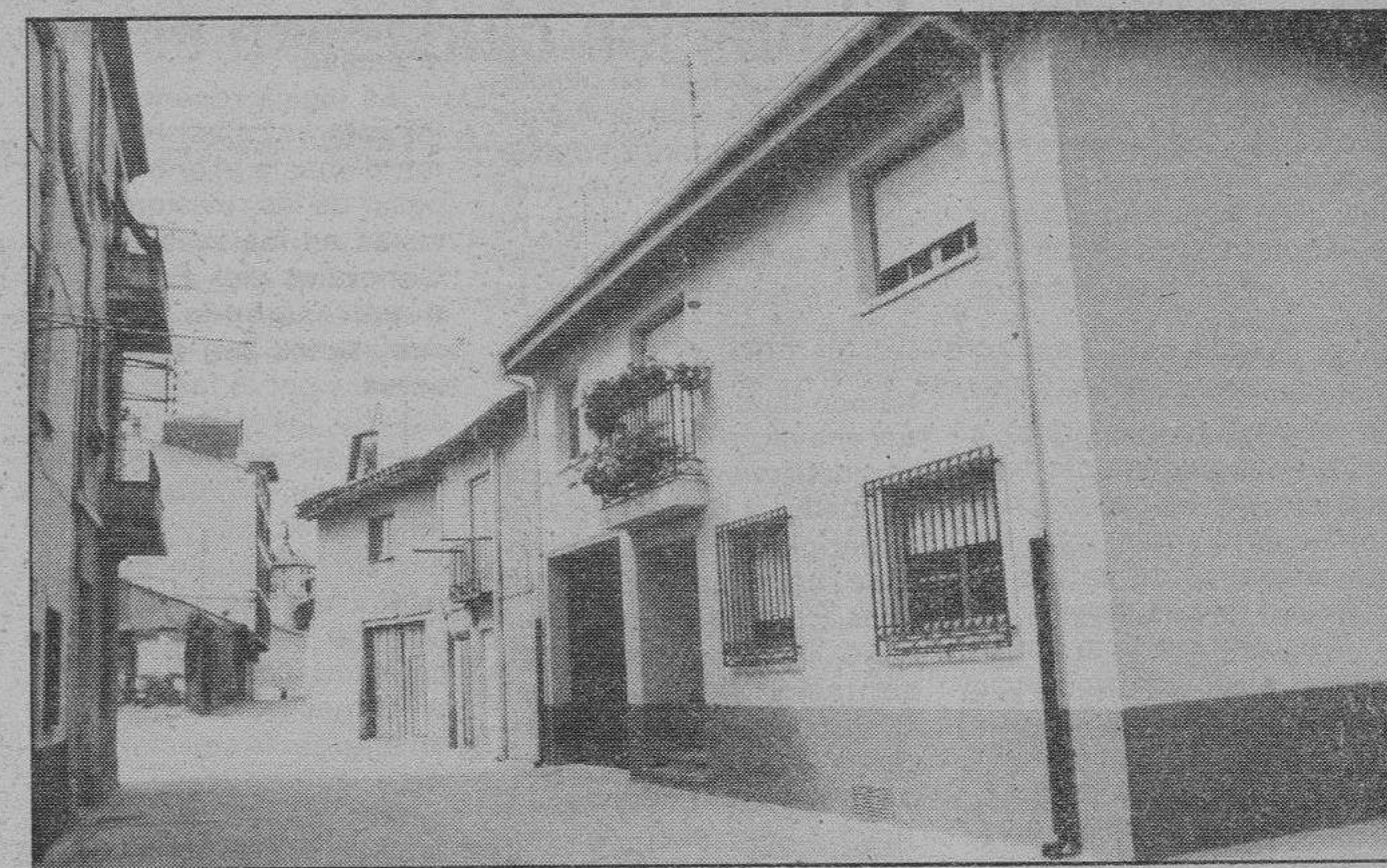
En el barrio de San Juan. — Actualmente se están realizando obras de limpieza y acondicionamiento en el barrio; algunos edificios han sido demolidos y se han construido casas nuevas que conservan perfectamente la armonía del entorno. Así puede apreciarse en las fotografías de Florentino Lara.
