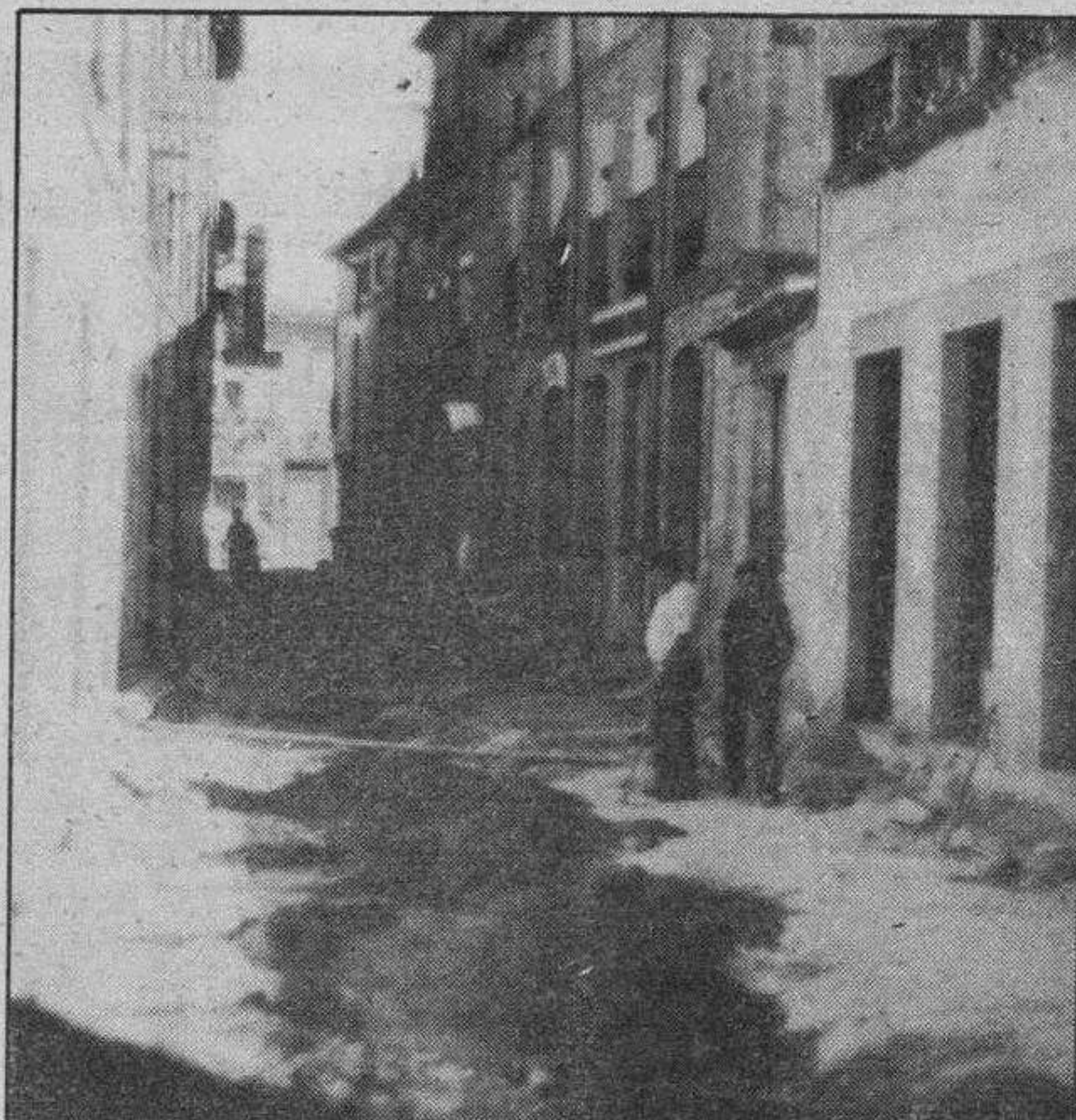
Obras de la Calleja de la Plaza. Foto Miguel Angel.
