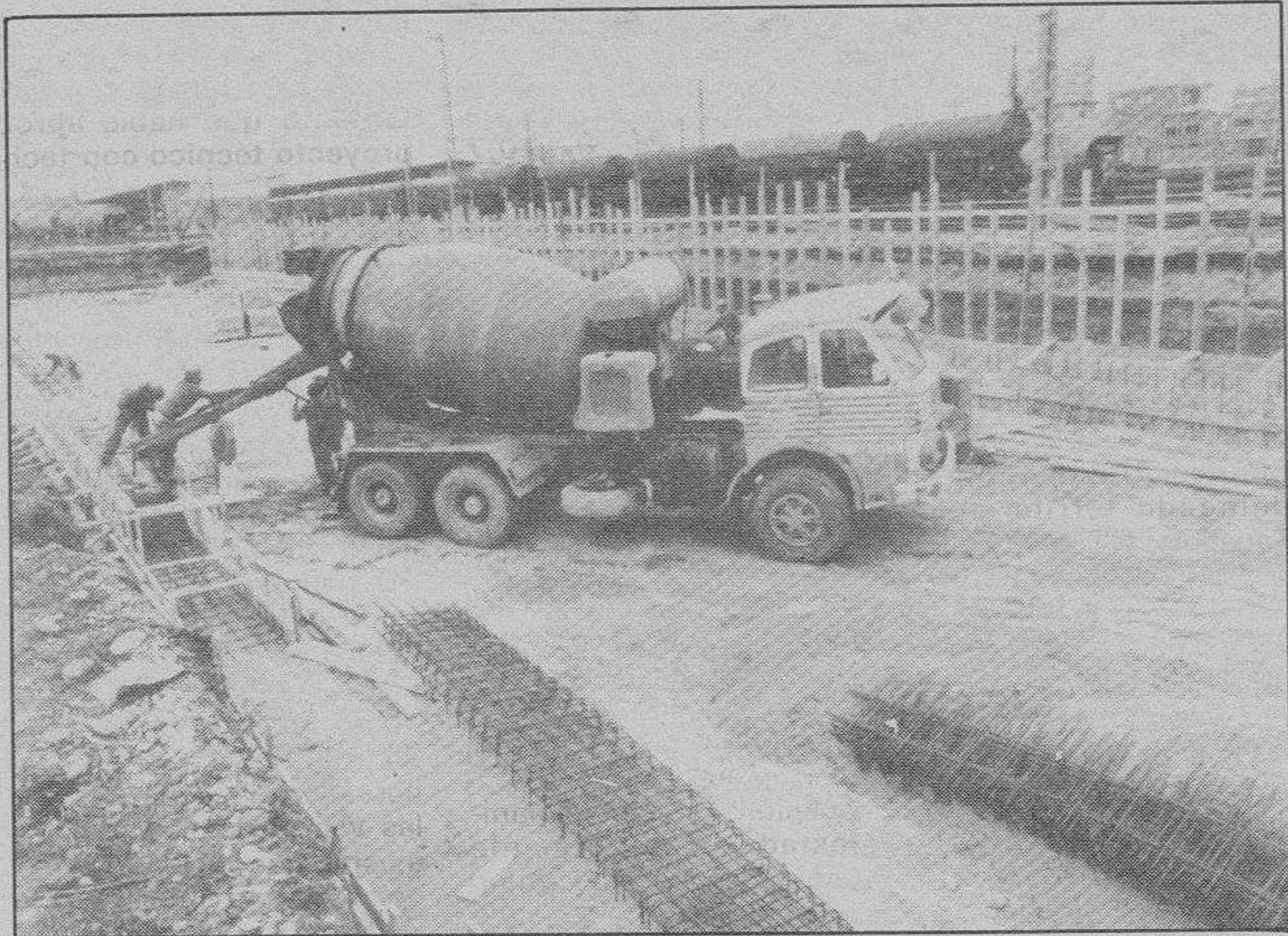
Siguen adelante las obras de las 140 viviendas.
