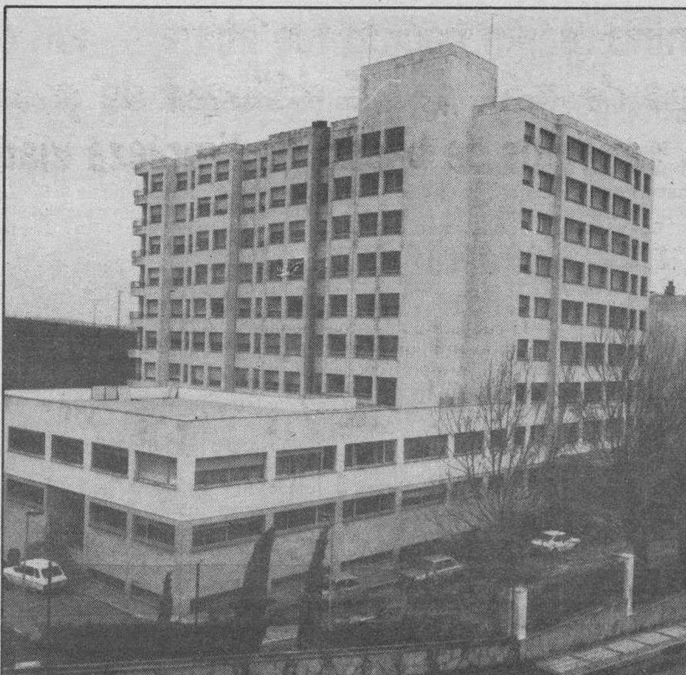
Residencia de pensionistas de la Seguridad Social (Camino de Cortes).
