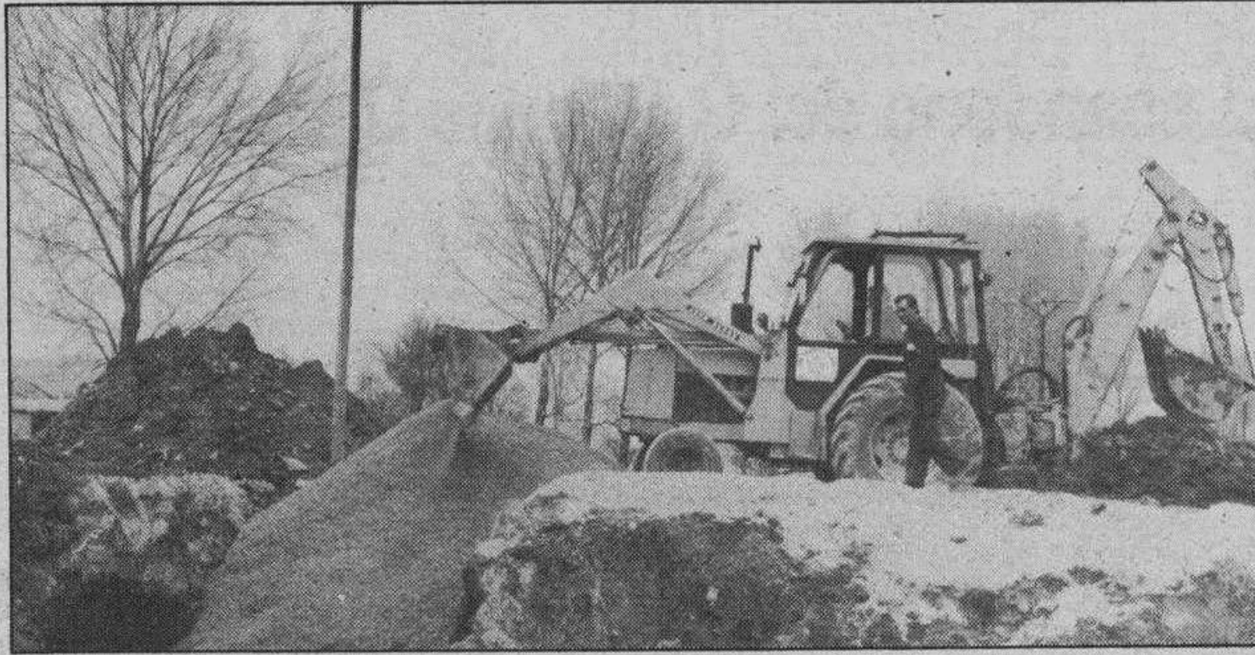
La arteria Plaza de Bilbao-Casa la Vega conectarán los depósitos del cerro de San Miguel y Villatoro
