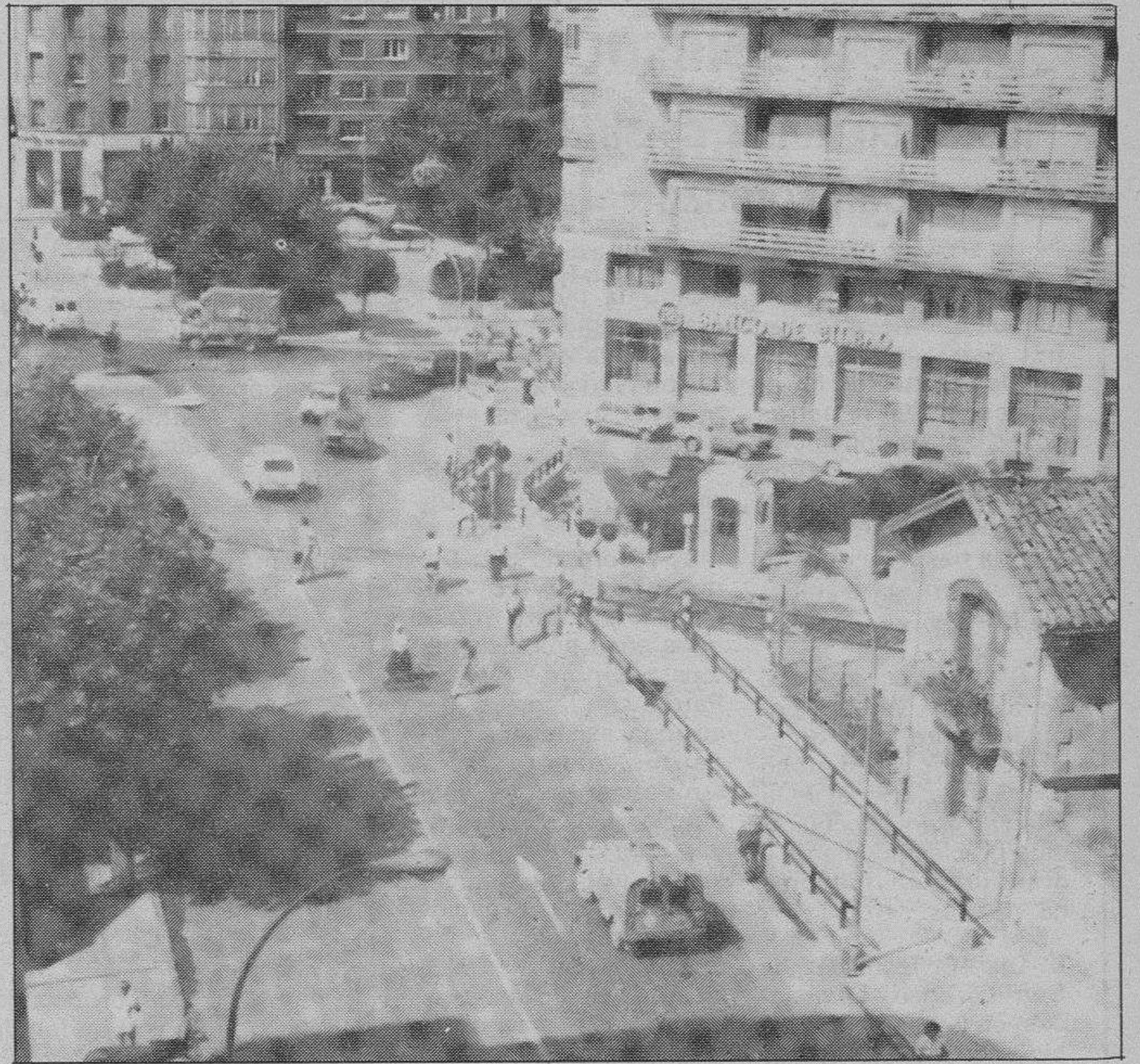
Paso a nivel de la línea Castejón-Bilbao en su estado actual que pronto será suprimido, lo que supondrá un gran acontecimiento urbanístico para Miranda de Ebro.
