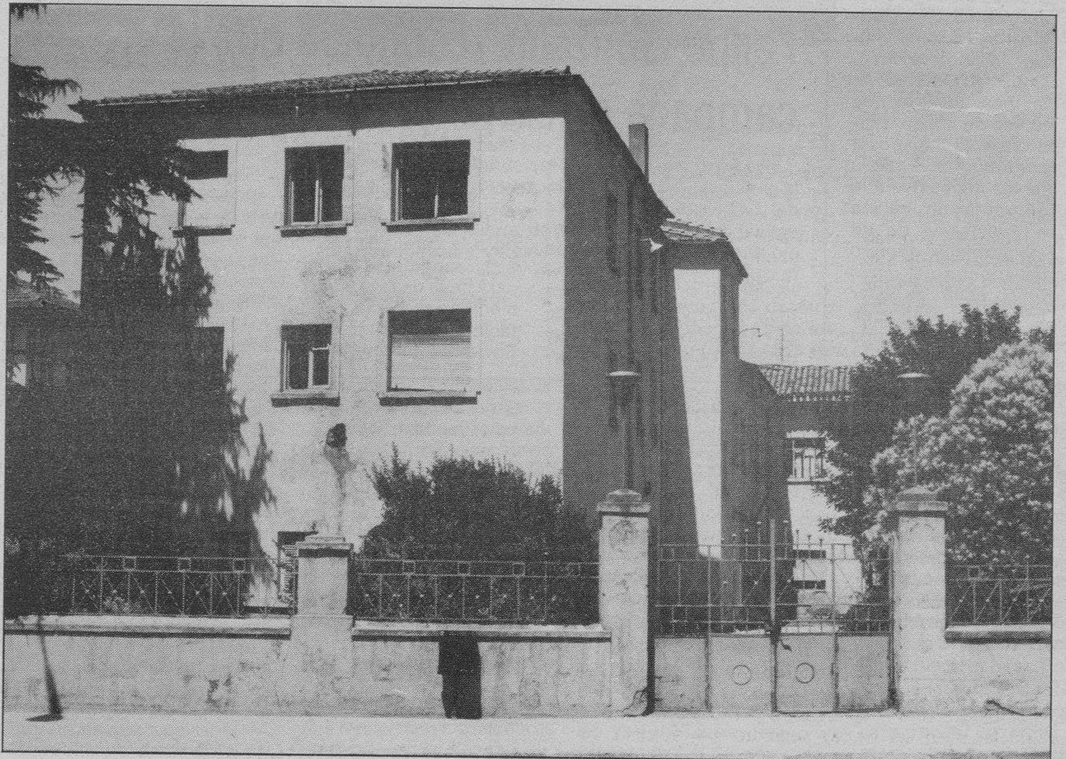
Patrimonio sindical. — Ya hay criterios de base para la futura Ley de devolución del patrimonio sindical. Este es uno de los edificios burgaleses que tiene esa consideración. Su grado de deterioro es tal que será preciso su derribo o gastarse lo mismo por su restauración. La medida de rehabilitación es urgente.
