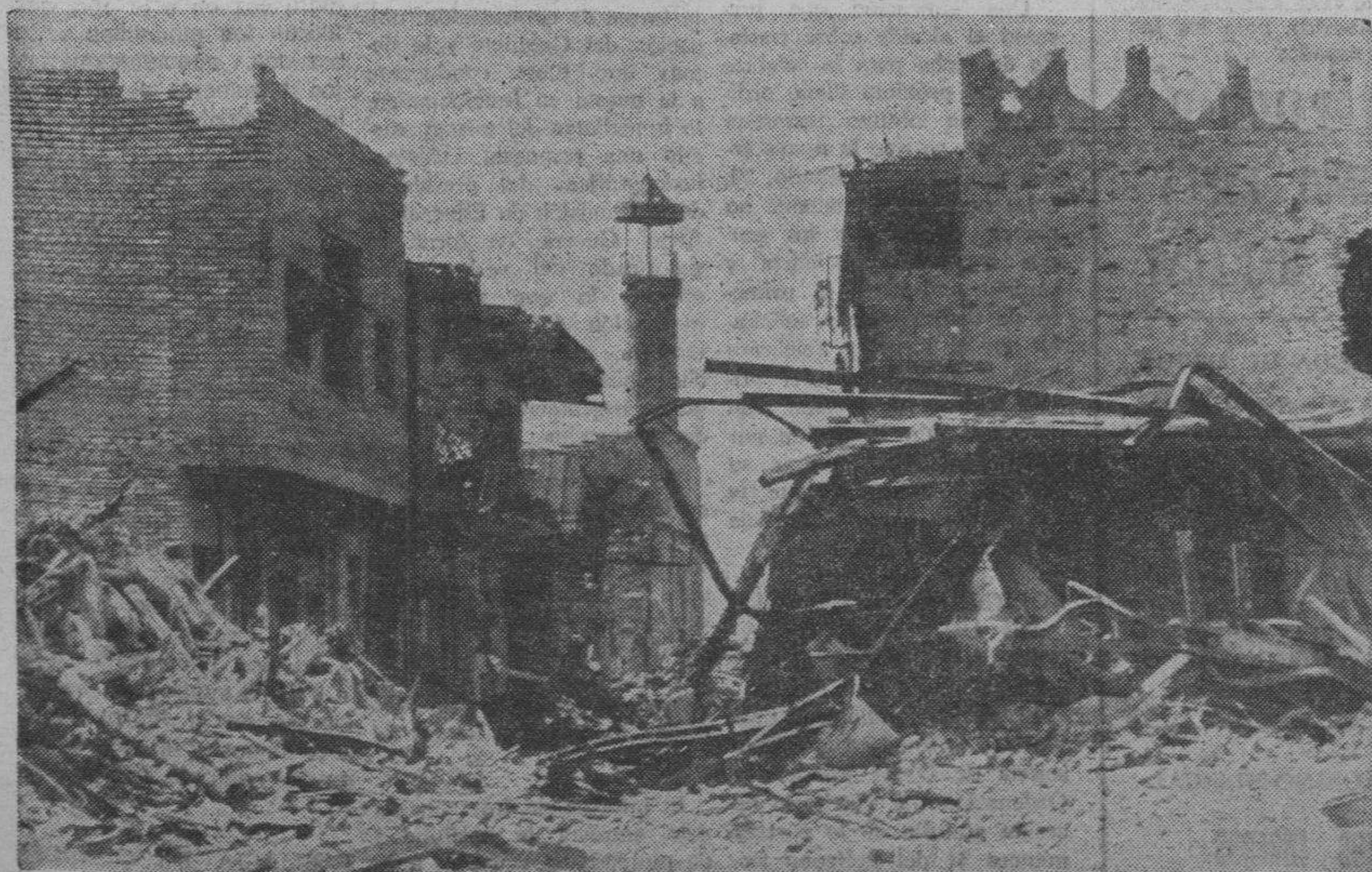
Khorramshar (Irán). — La torre de un minarete se levanta entre los restos del mercado de esta ciudad, tras un bombardeo. Este punto iraní, situado al Sur del país, fue demolida por los ataques aéreos iraquíes y ocupada por éstos en 1980. Más tarde, en 1982, fue recuperada por las tropas iraníes. — (Telefoto EFE-AP).
