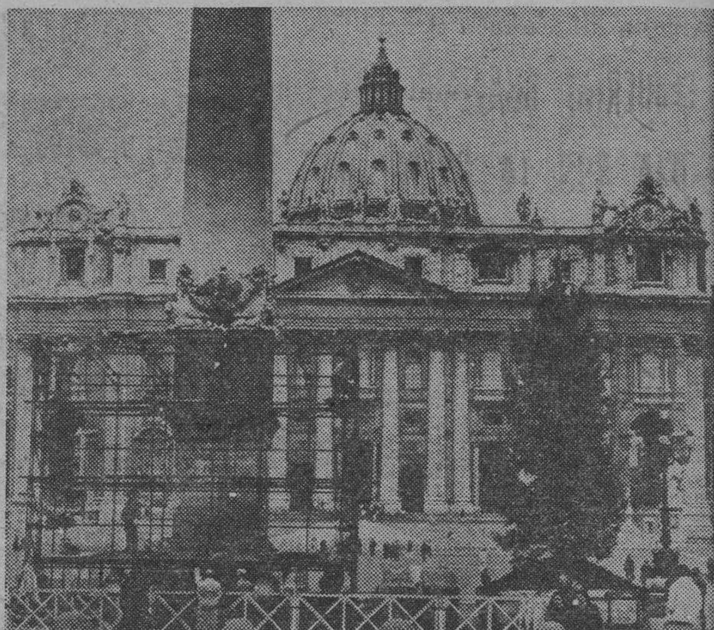
Ciudad del Vaticano. — Varios trabajadores colocan una plataforma para instalar un portal de Belén, junto a un árbol de Navidad de 13 metros de altura, en el centro de la plaza de San Pedro. Al fondo la Basílica. — (Telefoto Efe-Ap)
