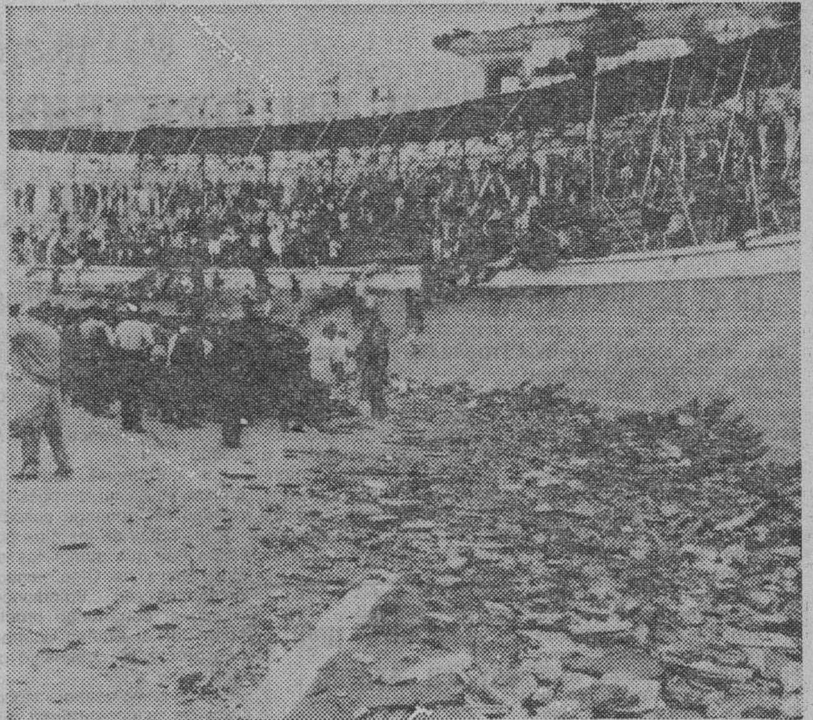
Argel (Argelia). — Diez personas resultaron muertas y trescientas heridas, al desplomarse el techo metálico del estadio «20 de Agosto», que cayó sobre los espectadores que asistían a un partido de fútbol. El accidente se produjo al haber un exceso de peso en el techo, al que se subieron unos jóvenes, para ver el partido. — (Telefoto Efe-Upi)
