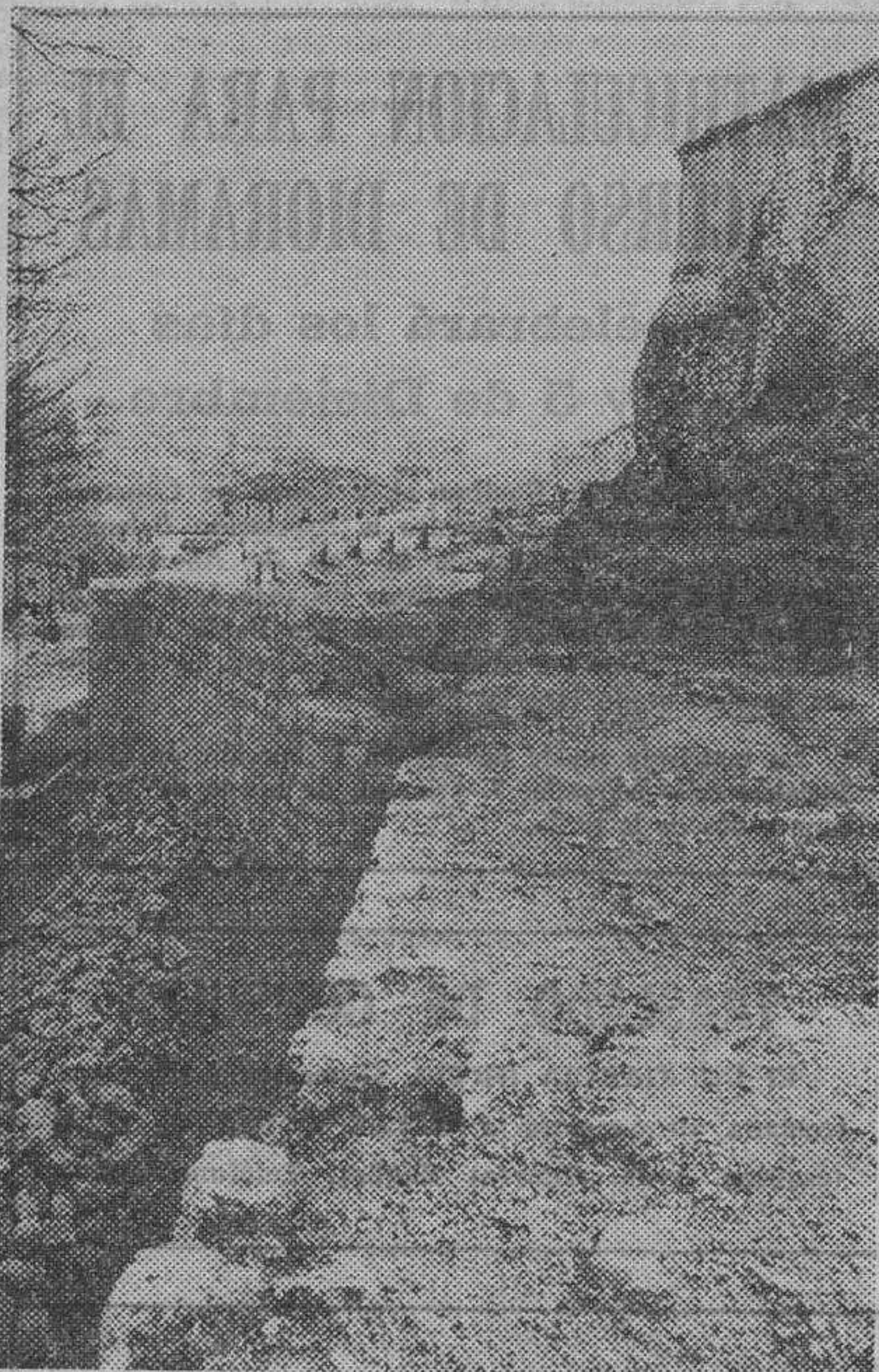
Restauración de la muralla en sus paños más próximos al arco mudéjar de San Esteban. — (Foto FEDE).
