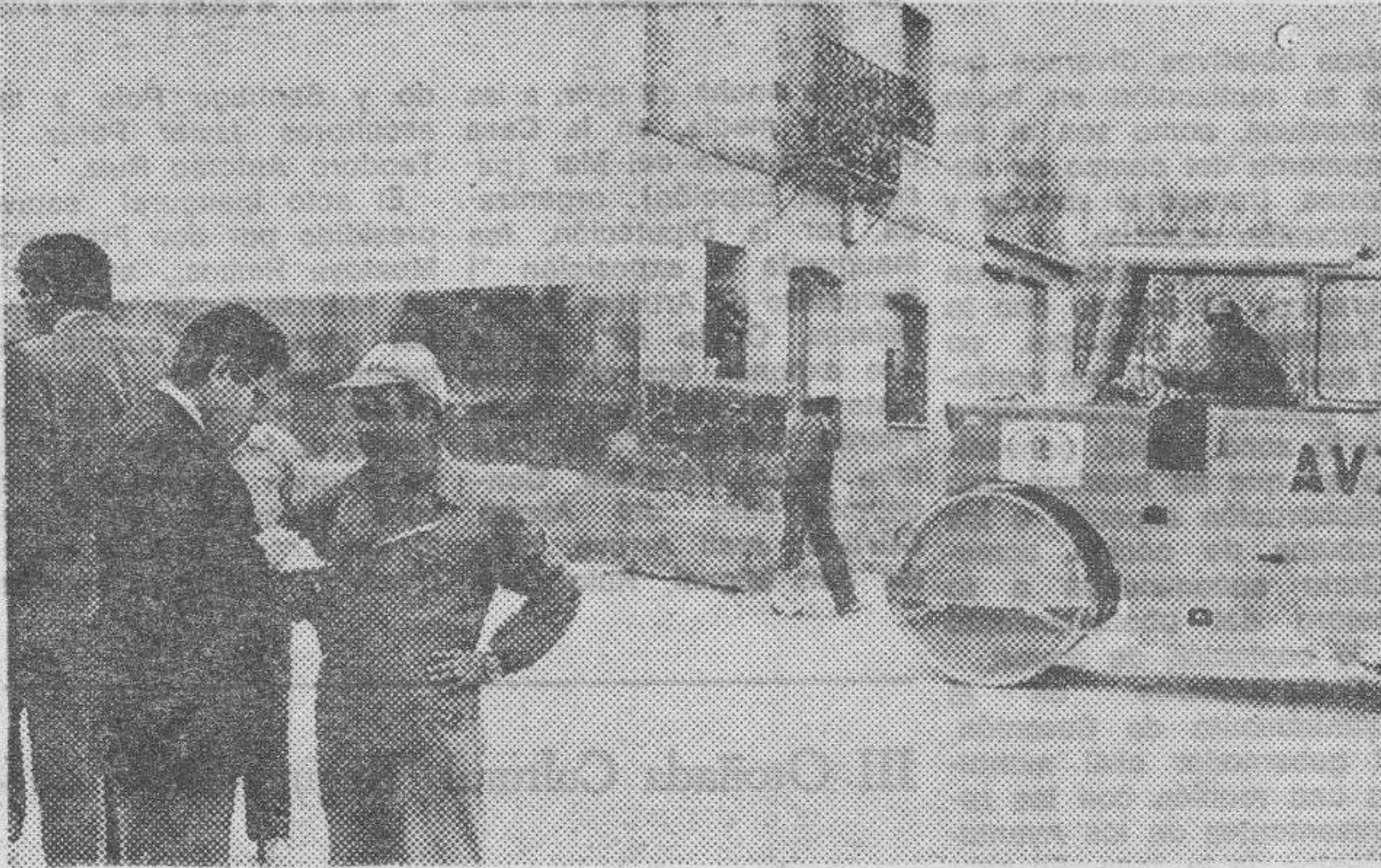
Paules del Agua ha pavimentado sus calles. El trabajo lo han realizado los vecinos por prestación personal, con la especial colaboración de uno de los Equipos de Ayuda Municipal de la Diputación. En el grabado, el señor Montoya conversando con uno de los técnicos al servicio de la Diputación. — (Foto FEDE)
