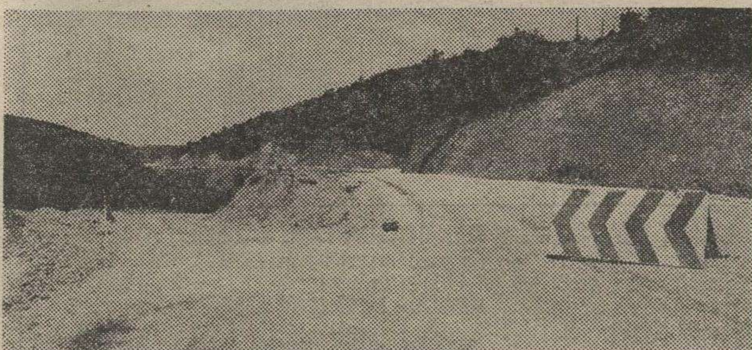
Las obras de la nueva carretera del pantano de Uzquiza están ya prácticamente concluidas. Ha sido desviada la anterior y de este modo se salva el acceso al nuevo embalse para cuando entre en funcionamiento, en una fecha, como saben nuestros lectores, no determinada todavía. Los problemas que tuvo la obra se solventaron y los trabajos se encuentran prácticamente finalizados. — (Foto FEDE).
