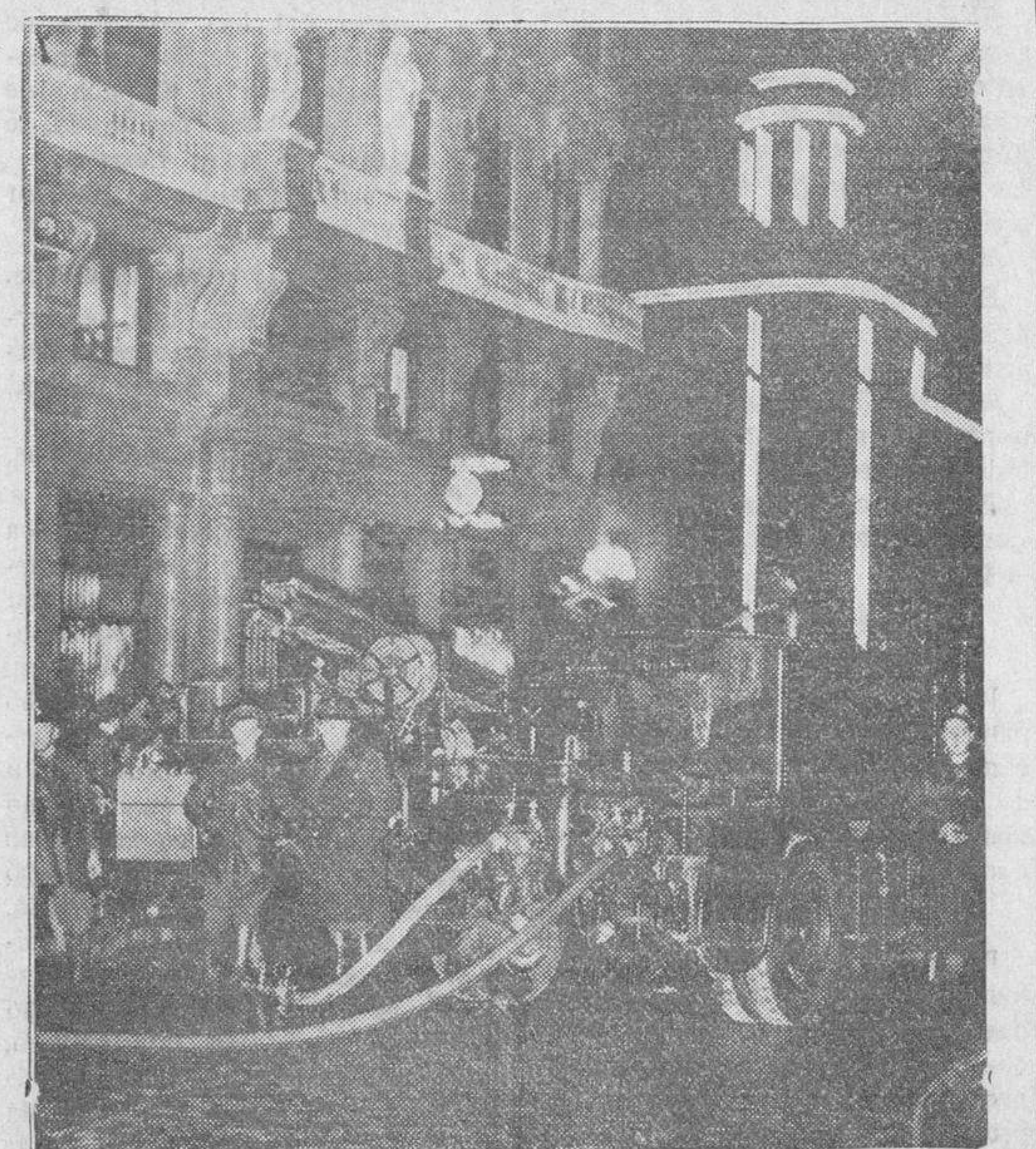
En un local dedicado a almacén y oficinas de una empresa cinematográfica, en el edificio de «La Adriática», se produjo un violentísimo incendio. He aquí el lugar del suceso durante la actuación de los bomberos para extinguir el fuego
