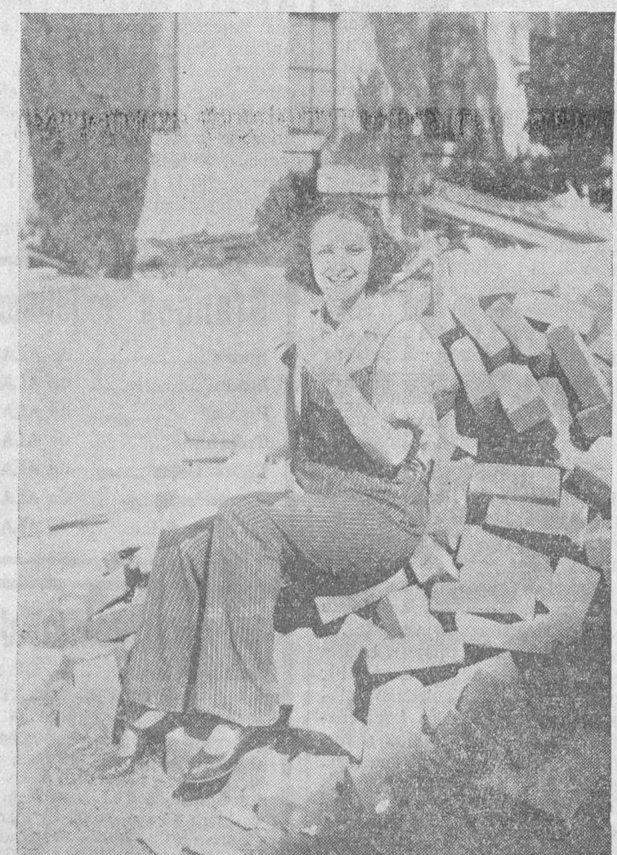
Florine McKinney, graciosa artista de la Metro-Goldwyn-Mayer, inspecciona, "en traje de carácter", las obras del nuevo edificio de guardarrropía que se está agregando a los estudios de dicha empresa.
