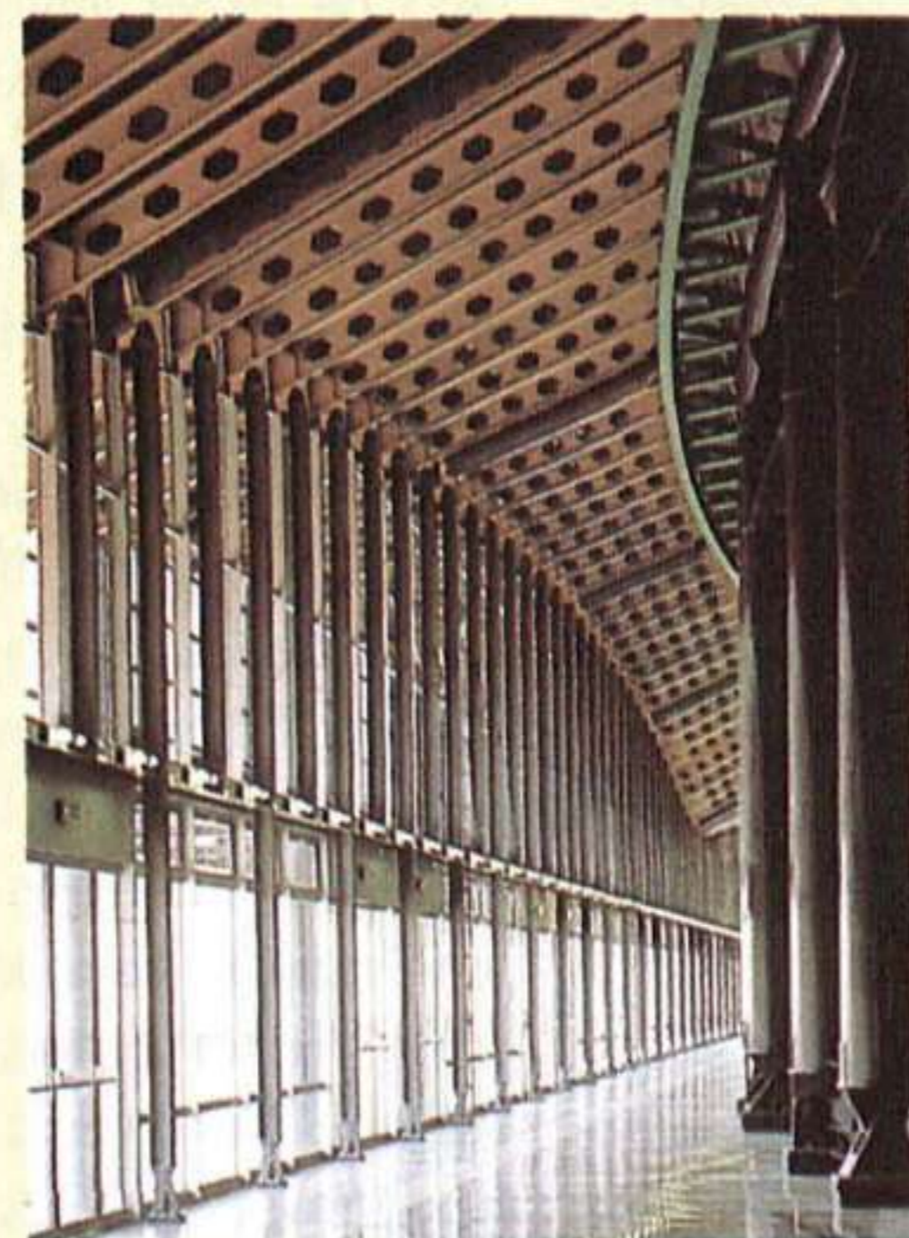
Palacio de los deportes de Montjuïc.
