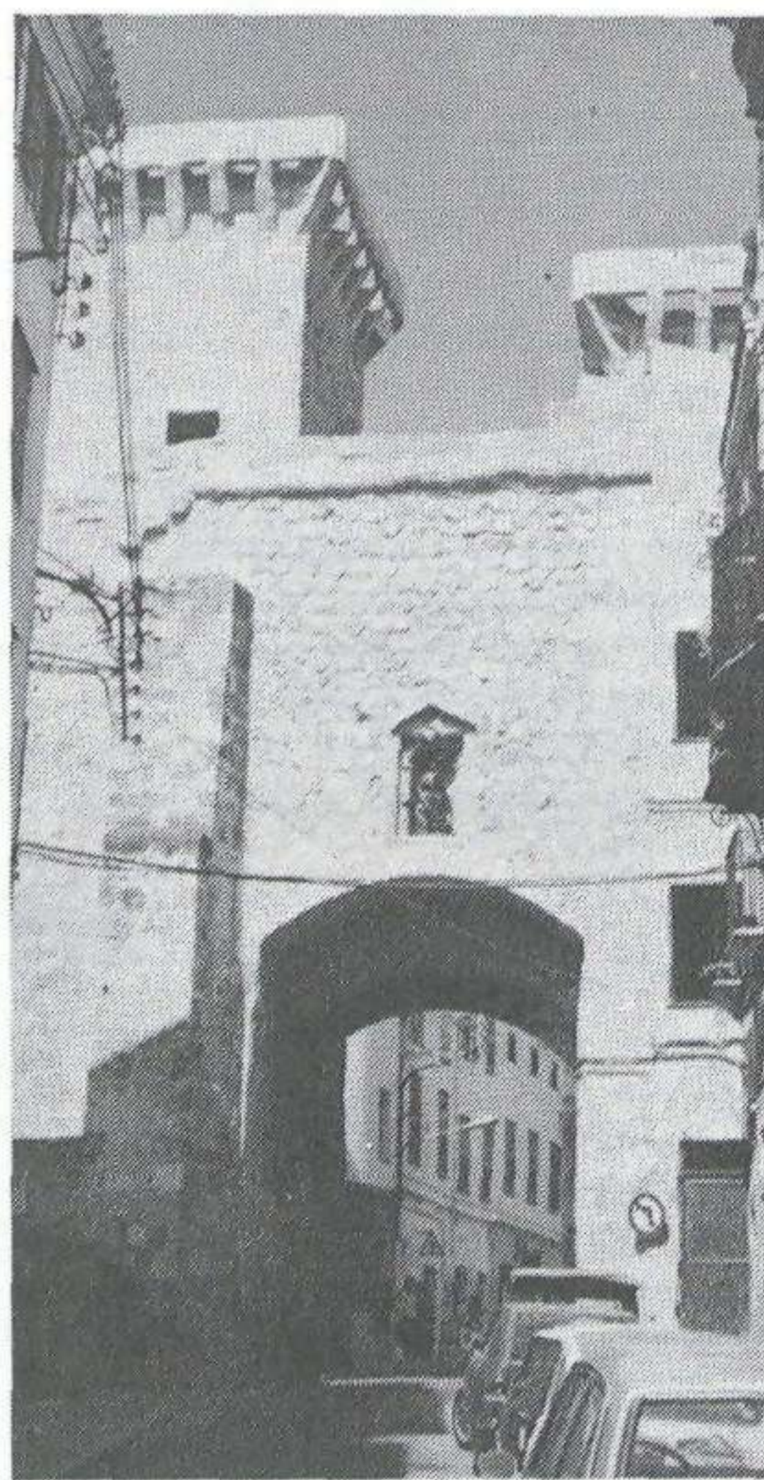
Torre de San Roque
