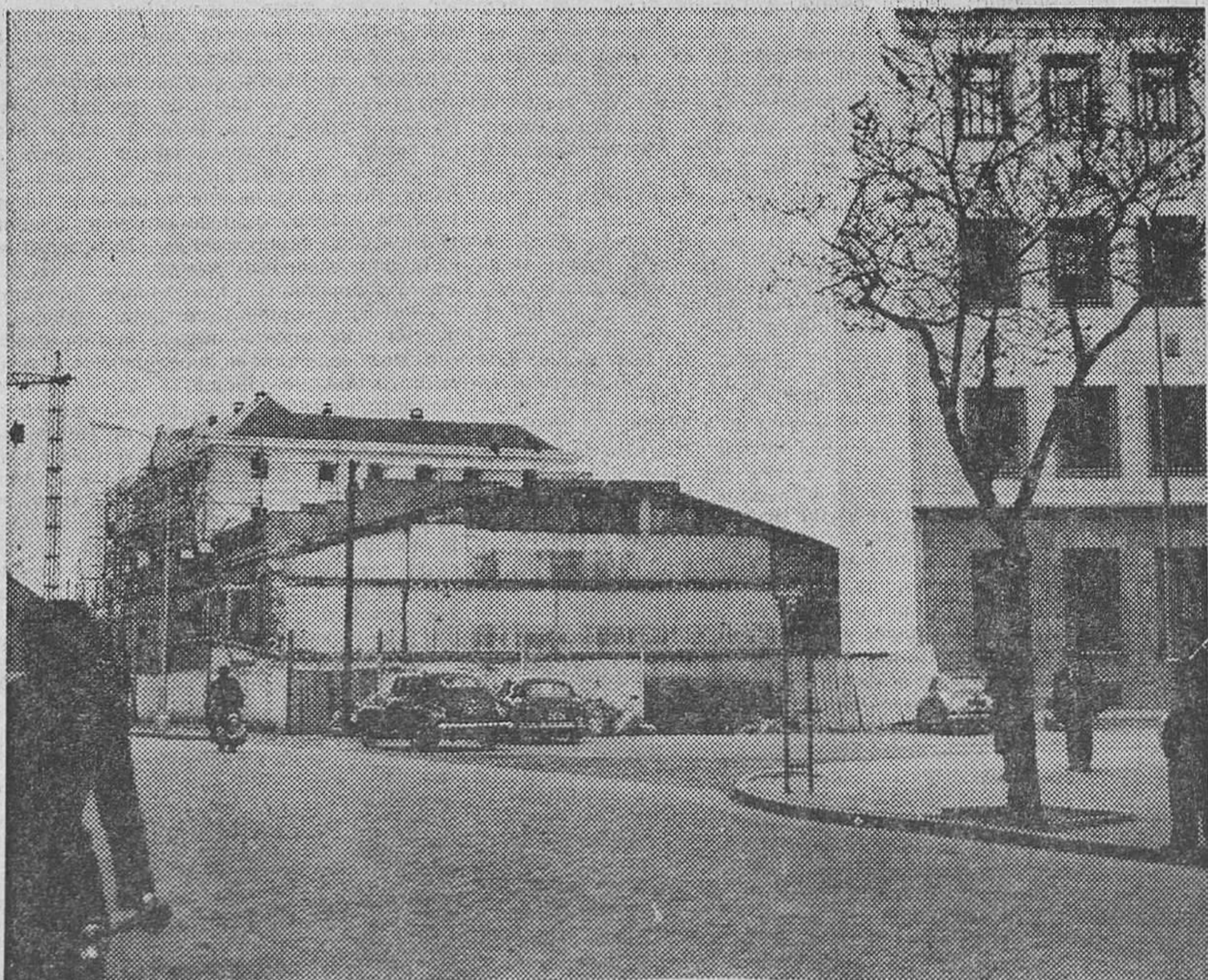
«Unos treinta años separarán en el tiempo a estas dos fotografías de «FEDE». Se trata de la esquina que forman la calle de Vitoria, en el antiguo puente «De las viudas» y esa parte del cauce del Vena. El derribo de viejas edificaciones dio paso a otras modernas, como el hotel «Almirante Bonifaz», que aparece así en nuestros días, rodeado de automóviles».
