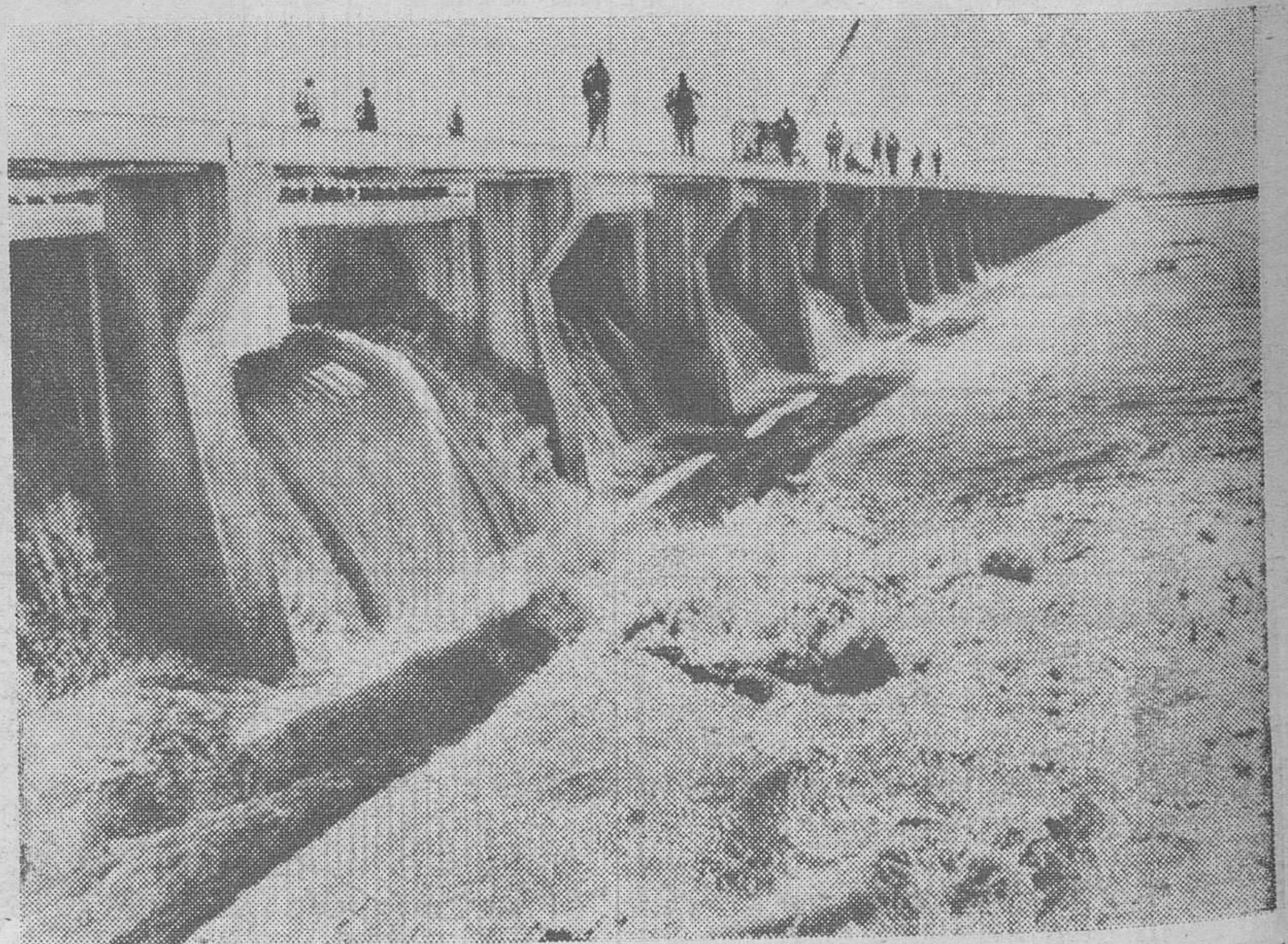
Norco (Luisiana). — Agua enfiada del Mississippi alluye por el dique «Bomet Carre Spillway», en tanto que miembros del Cuerpo de Ingenieros abren las compuertas, para evitar que la concentración de agua amenace a Nueva Orleans, situada a 48 kilómetros de distancia, río abajo. La última vez que se abrieron las compuertas fue en 1950 y ésta es la cuarta vez que han sido abiertas a causa del aumento del caudal del agua, desde que se construyó en 1929. (Telefoto CIFRA GRAFICA-UPI).
