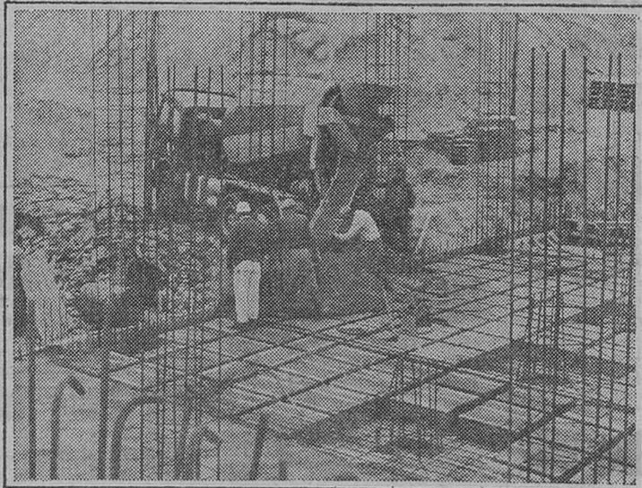
Hacen falta 200.000 m<sup>3</sup> de hormigón para construir unos edificios. Los camiones-hormigonera Pegaso 3.060 GI, de 200 cv., los llevan. La gran solidez de su bastidor, así como la de su eje delantero, el puente posterior, previsto de un sistema de bloqueo a voluntad, mediante un tercer diferencial, permiten a este Pegaso actuar en terrenos difíciles. Con suspensión especial trasera mediante tacos de goma. Y a servo-dirección, con mando hidráulico, posibilita una conducción más cómoda.
