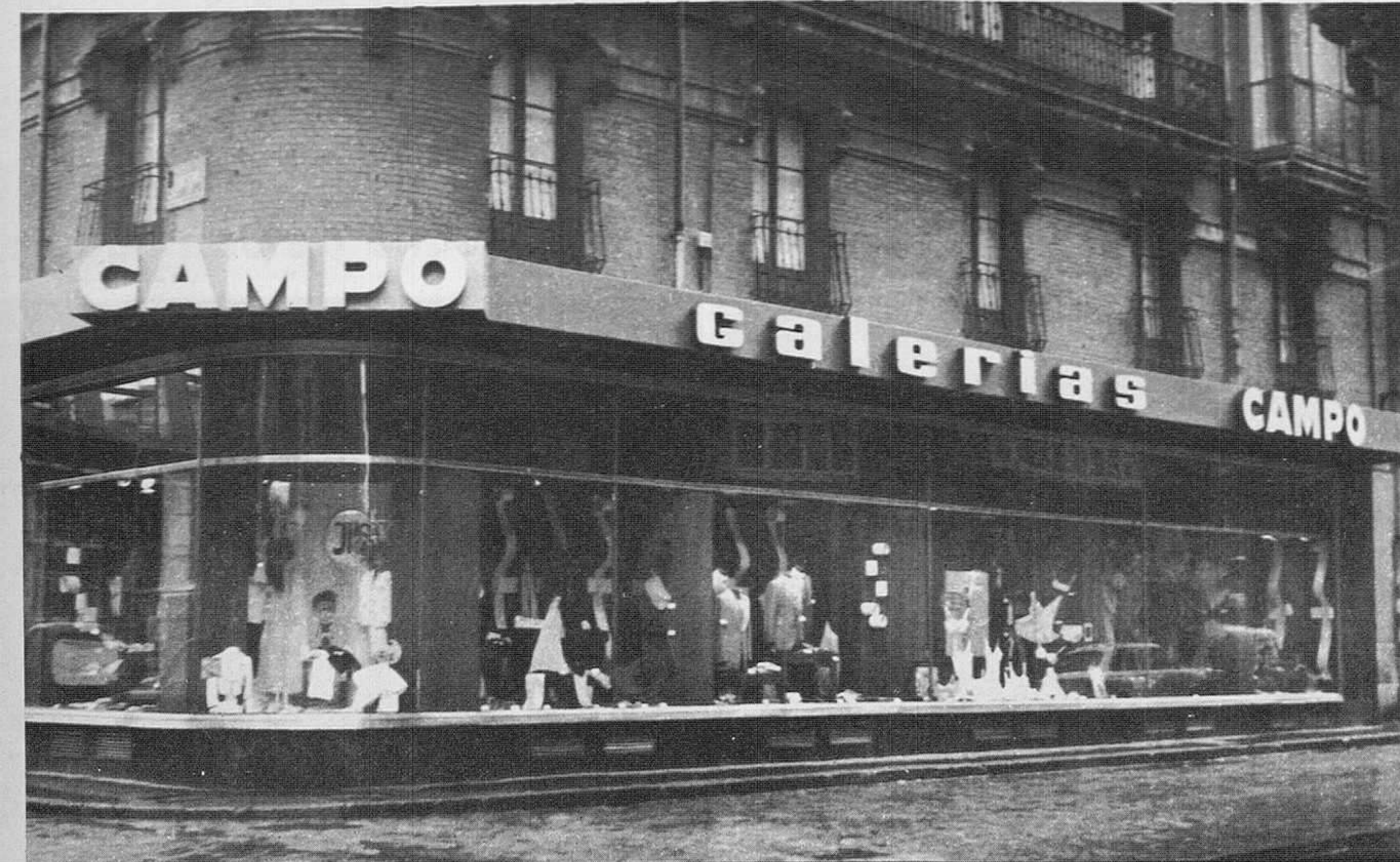
Galerías Campo Esquina calle San Juan
