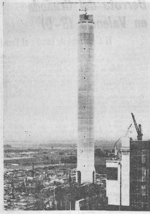
Con 259 metros de altura, la chimenea de la central eléctrica de Drax, en el Noroeste de Inglaterra, está considerada como la más alta de Europa. En realidad con su construcción no se ha pretendido establecer un récord sino que se ha necesitado esta elevación para superar los problemas de la contaminación atmosférica, esa "plaga" que amenaza y corroe nuestro planeta. (Foto Fiel)
