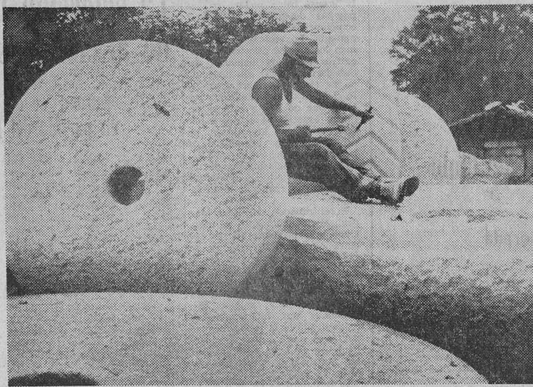
En los tiempos de las modernas trituradoras y prensas hidráulicas, todavía se siguen utilizando estos enormes bloques cilíndricos de granito, para moler la aceituna en algunos lugares de Italia. Este picapedrero realiza, a golpe de martillo, las estrías de las ruedas, en un lugar cercano al Lago Maggiore, en Baveno. Su tarea es tan delicada como la de un escultor (Foto FIEL)
