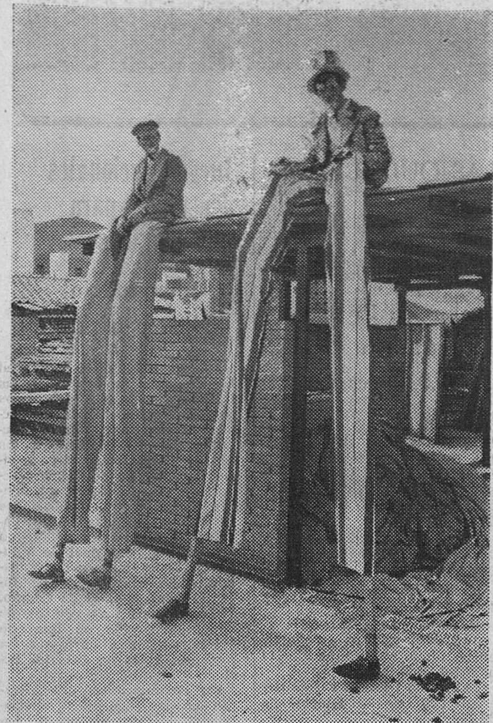
Para tales «piernas», tales asientos. Estos zanquilargos que actúan en un circo instalado en Hospitalet de Llobregat, Barcelona, descansan sobre el tejado de un cobertizo tras su actuación. Es la única silla adecuada para ellos... — (Foto FIEL).
